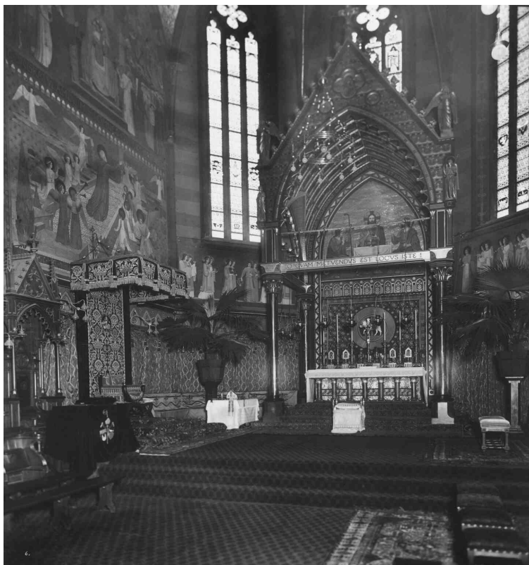
Obr. 6 Kostel, pohled do závěru presbytáře (kolem 1910)
