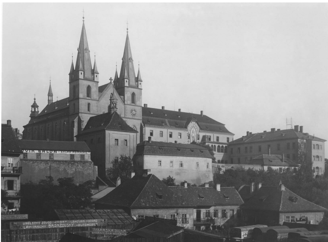
Obr. 25 Pohled na Emauzský klášter po dokončené beuronské přeměně (1910)
