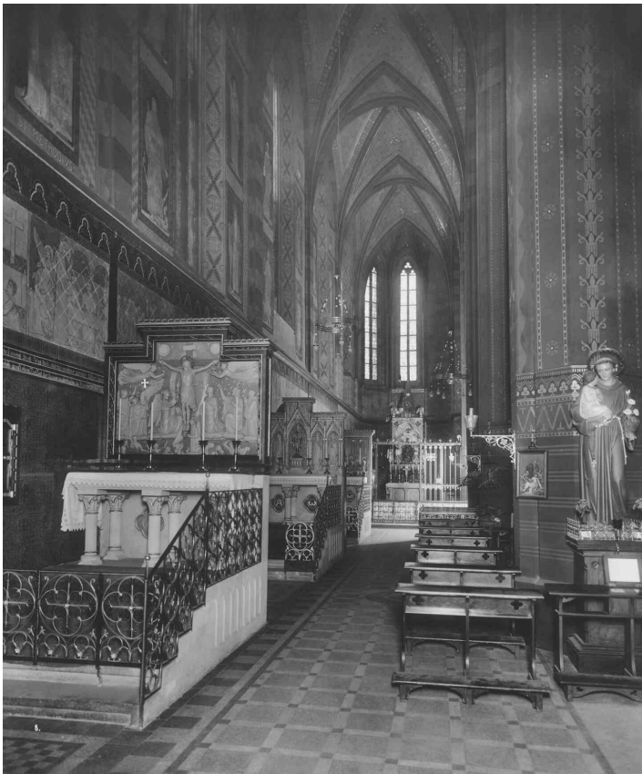
Obr. 14 Kostel, Průhled severní boční lodí (kolem 1910)
