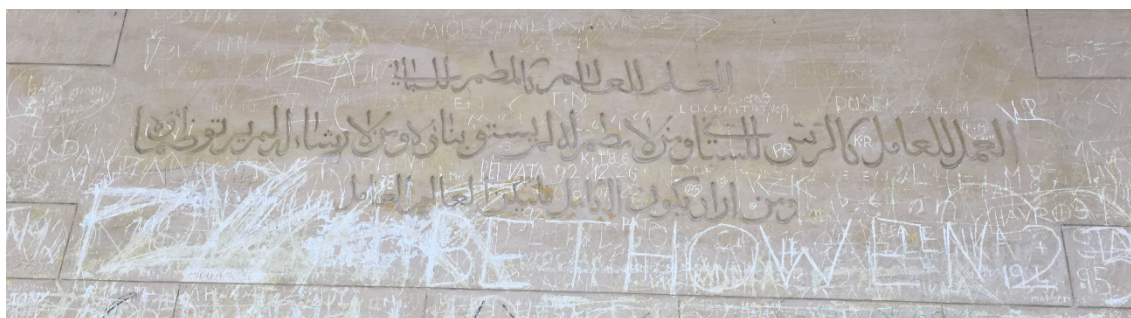
OBR / 13 INSKRIPCE NA ZADNÍ STĚNĚ VNĚJŠÍHO PLÁŠTĚ MINARETU
