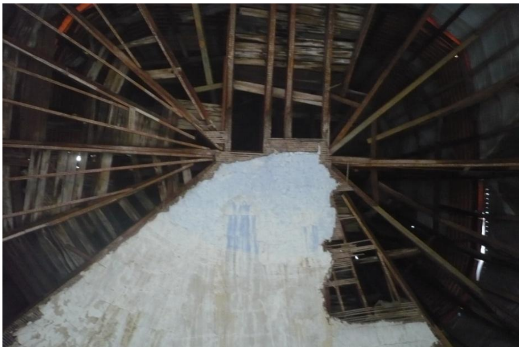
23. Rozbělesy , kostel sv. Václava, 1731–1783, pohled na dochovanou část klenby hlavní lodě
