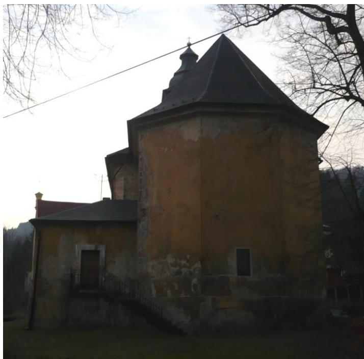
27. Bělá , kostel sv. Františka Xaverského, 1788, pohled na výhodní průčelí
