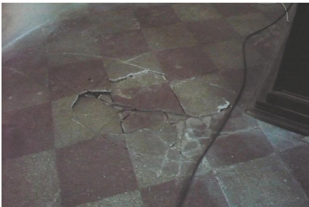
58. Arnoltice , kostel Nanebevzetí Panny Marie, 1756–1758, detail rozpraskaných dlaždic podlahy v severní části hlavní lodi
