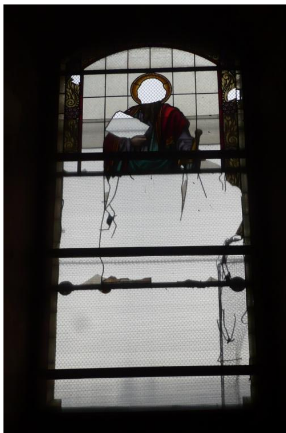
38. Bělá , kostel sv. Františka Xaverského, 1788, vitraj jižního okna hlavní lodi se zobrazením sv. Pavla, současný stav
