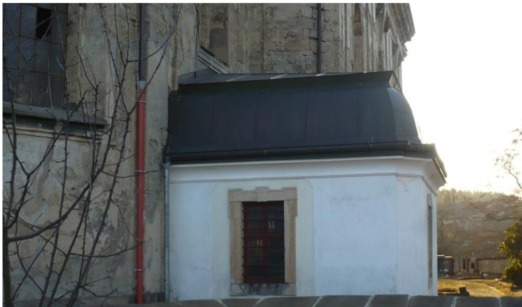
52. Arnoltice , kostel Nanebevzetí Panny Marie, 1756–1758, pohled na severní sakristii
