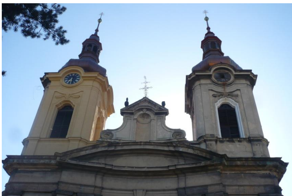
20. Rozbělesy , kostel sv. Václava, 1731–1783, pohled na opravené věže západního průčelí
