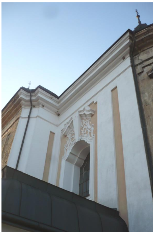
50. Arnoltice , kostel Nanebevzetí Panny Marie, 1756–1758, pohled na opravenou část presbytáře
