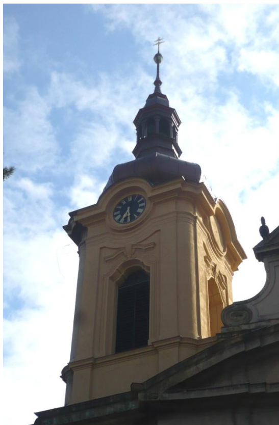
14. Rozbělesy , kostel sv. Václava, 1731–1783, opravená severní věž
