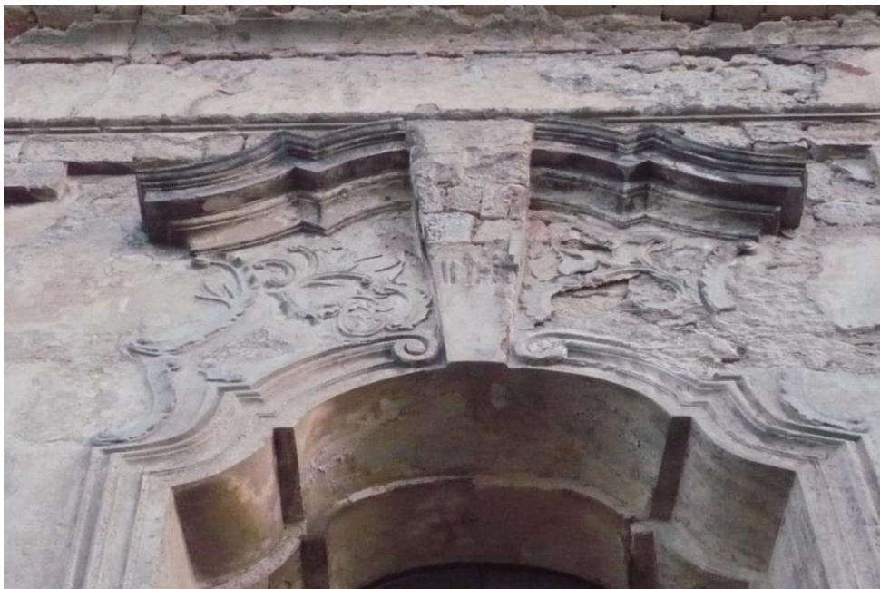
57. Arnoltice , kostel Nanebevzetí Panny Marie, 1756–1758, detail odlupující se štukové výzdoby severního okna hlavní lodi.
