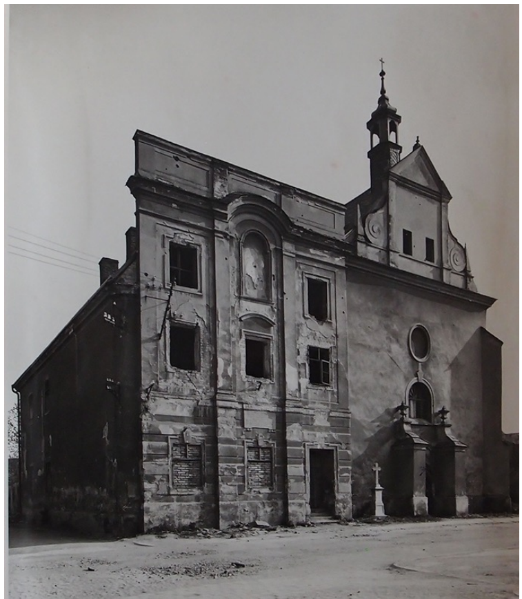
18. Špitál a kostel sv. Ducha, stav před rekonstrukcí,
