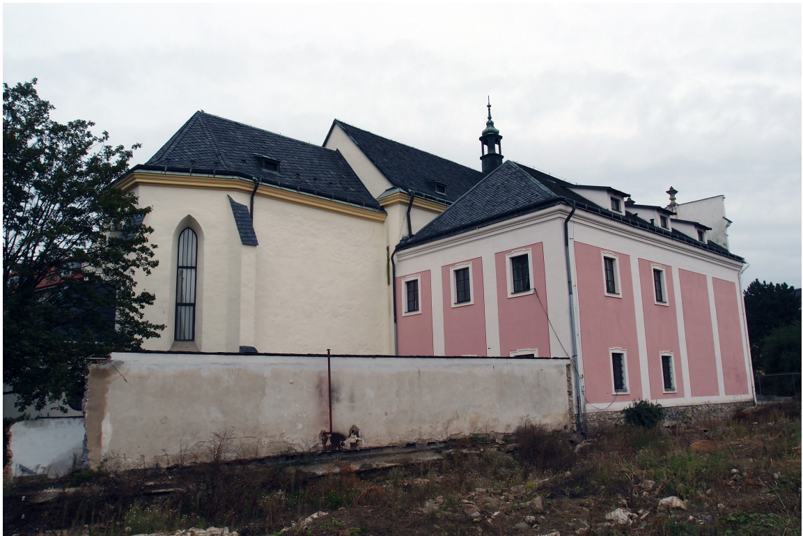
41. Pohled na špitál ze zadní části, pohled z jihu na sever.
