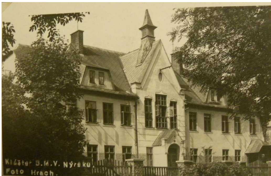
20. Nýrsko, ústav sester IBMV, 19. století, stav po roce 1930, pohled severovýchodu
