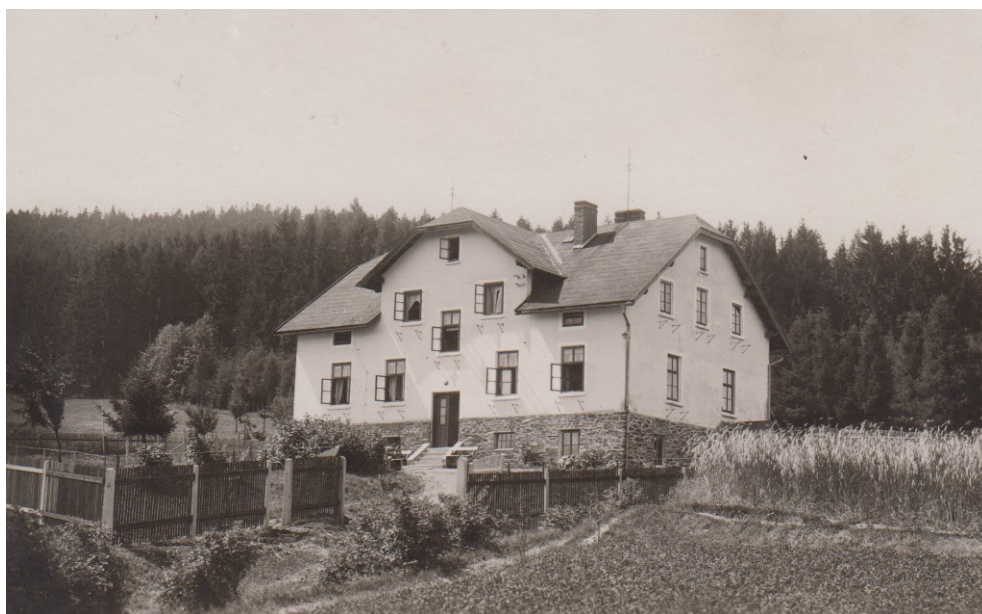
66. Nýrsko, vila Hubertus, rekreační dům sester IBMV, zakoupen 1917, stav po roce 1930, pohled od jihovýchodu
