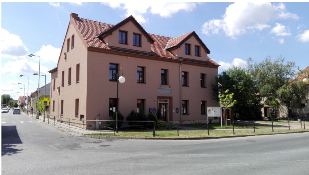
Obr. 6. Původní budova školy. Nachází se naproti kostelu, po rekonstrukci.
