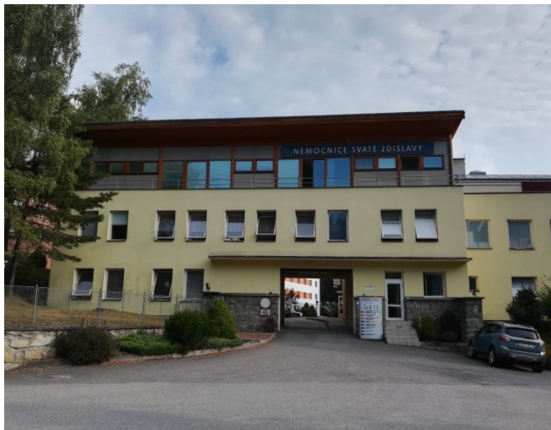
Obr. 47: Nemocnice Mostiště (2018). Archiv autorky.
