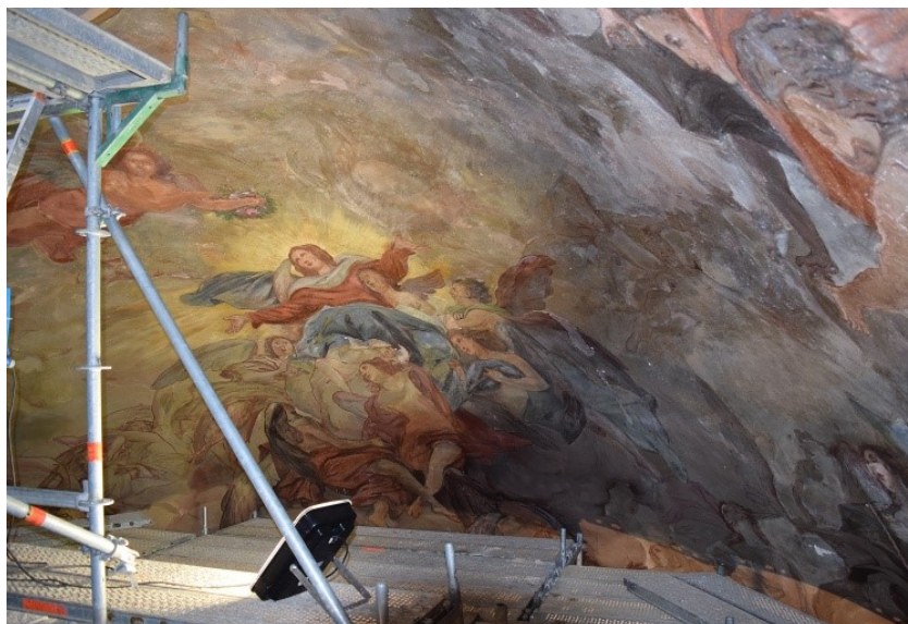
Obr. 38 - Pohled na obraz Nanebevzetí Panny Marie z lešení před zahájením restaurovských prací, únor 2017
