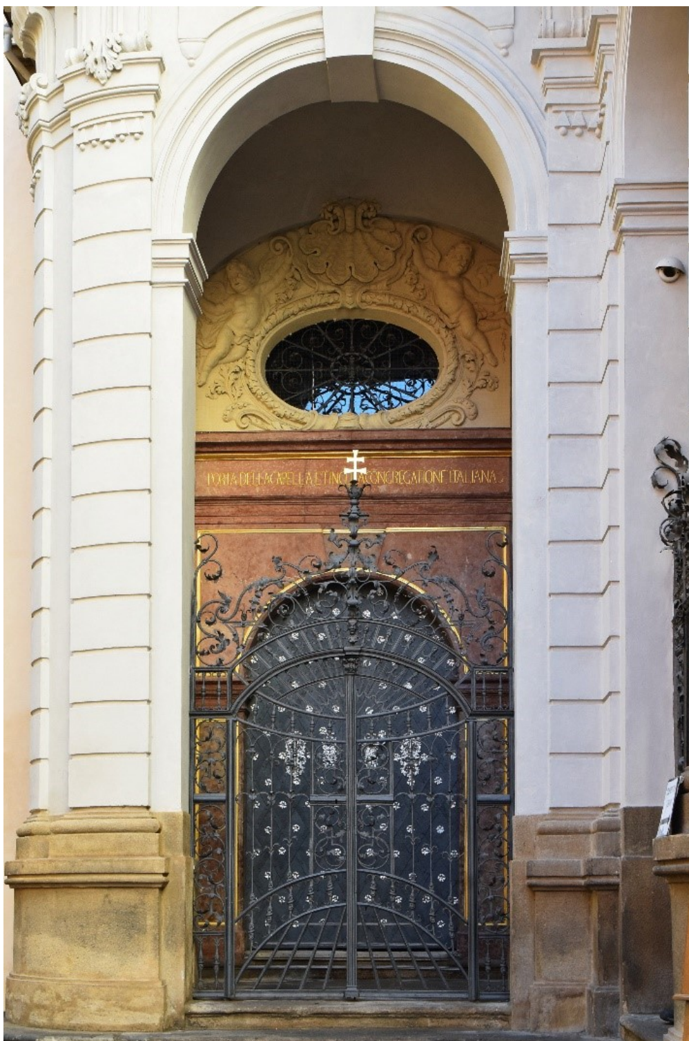
Obr. 11 – Vstupní portál kaple s tepanou mříží
