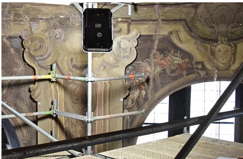
Obr. 37 - Lešení v kupoli kaple před zahájením druhé etapy prací (restaurování fresek), únor 2017
