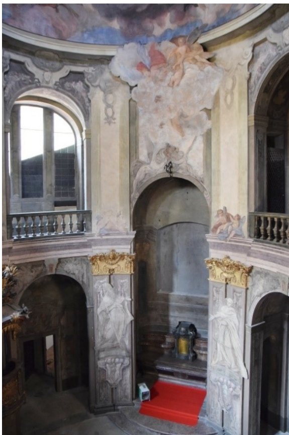
Obr. 15 - Pohled do interiéru kaple z horního ochozu směrem k západu k hlavnímu oltáři (po levé straně v přízemí vstup do sakristie a ke schodišti na ochoz), únor 2018
