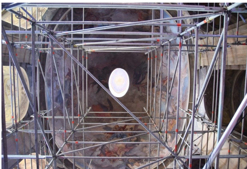
Obr. 44 a 45 - Lešení v kupoli před dokončením prací, den před oficiálním znovuotevřením kaple, 21. června 2017
