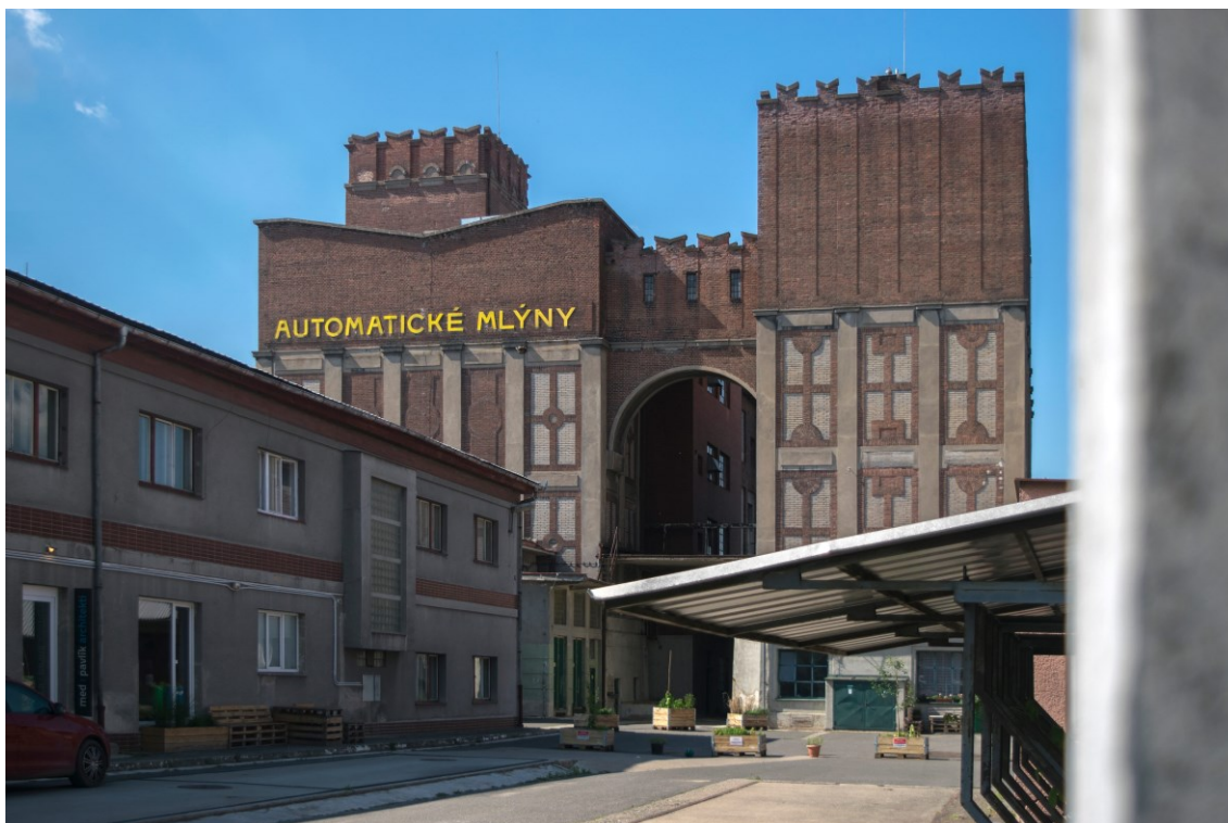
30. Pohled na jižní průčelí, současný stav
