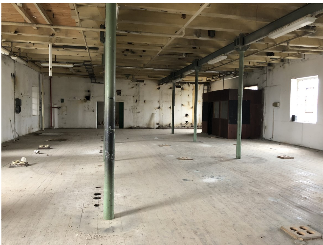
23. Otvory v patrech mlýnice pro umístění moukovodů, současný stav
