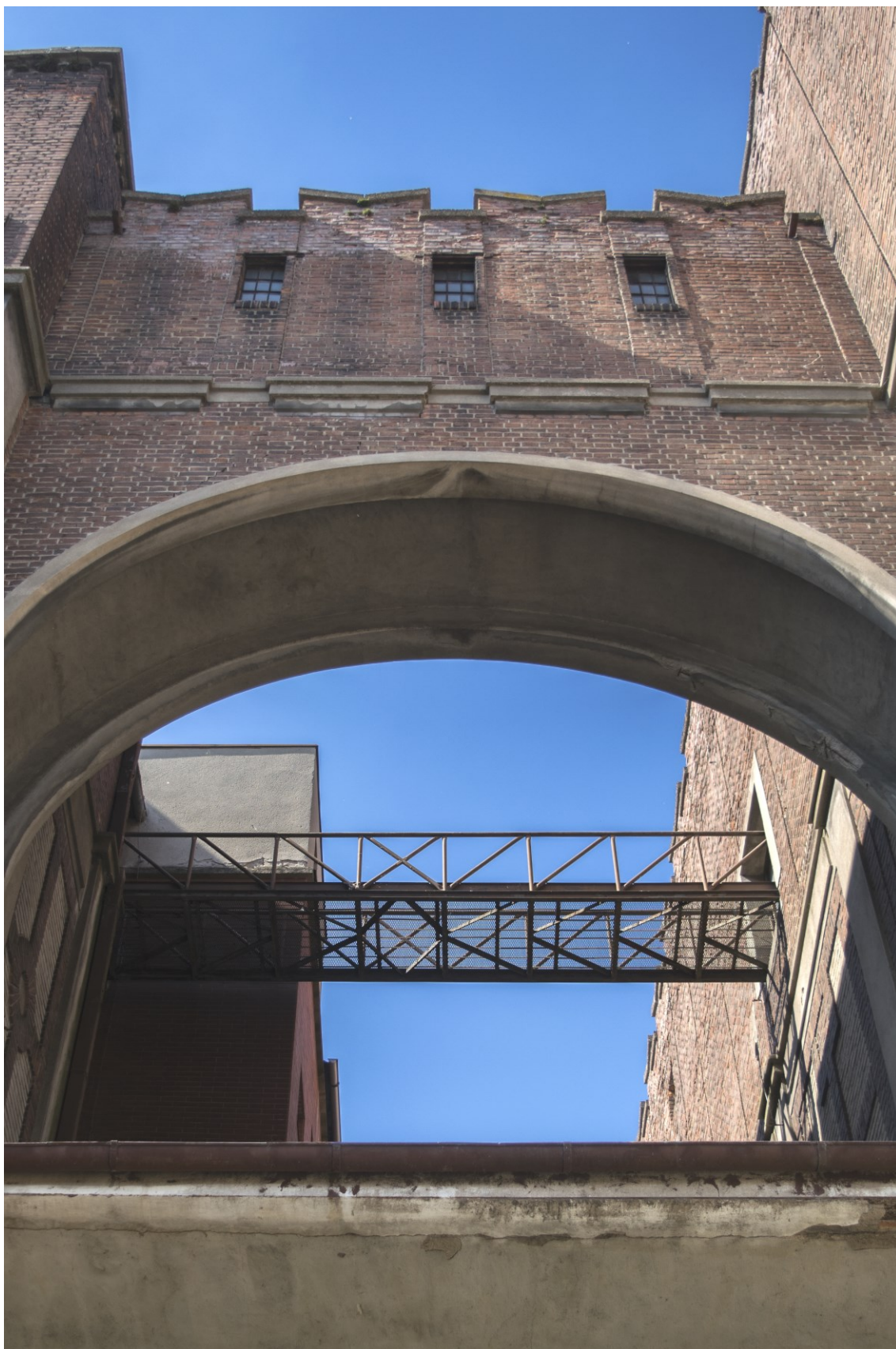
32. Spojovací trakt mezi budovou z roku 1911 a sílem z roku 1926, současný stav
