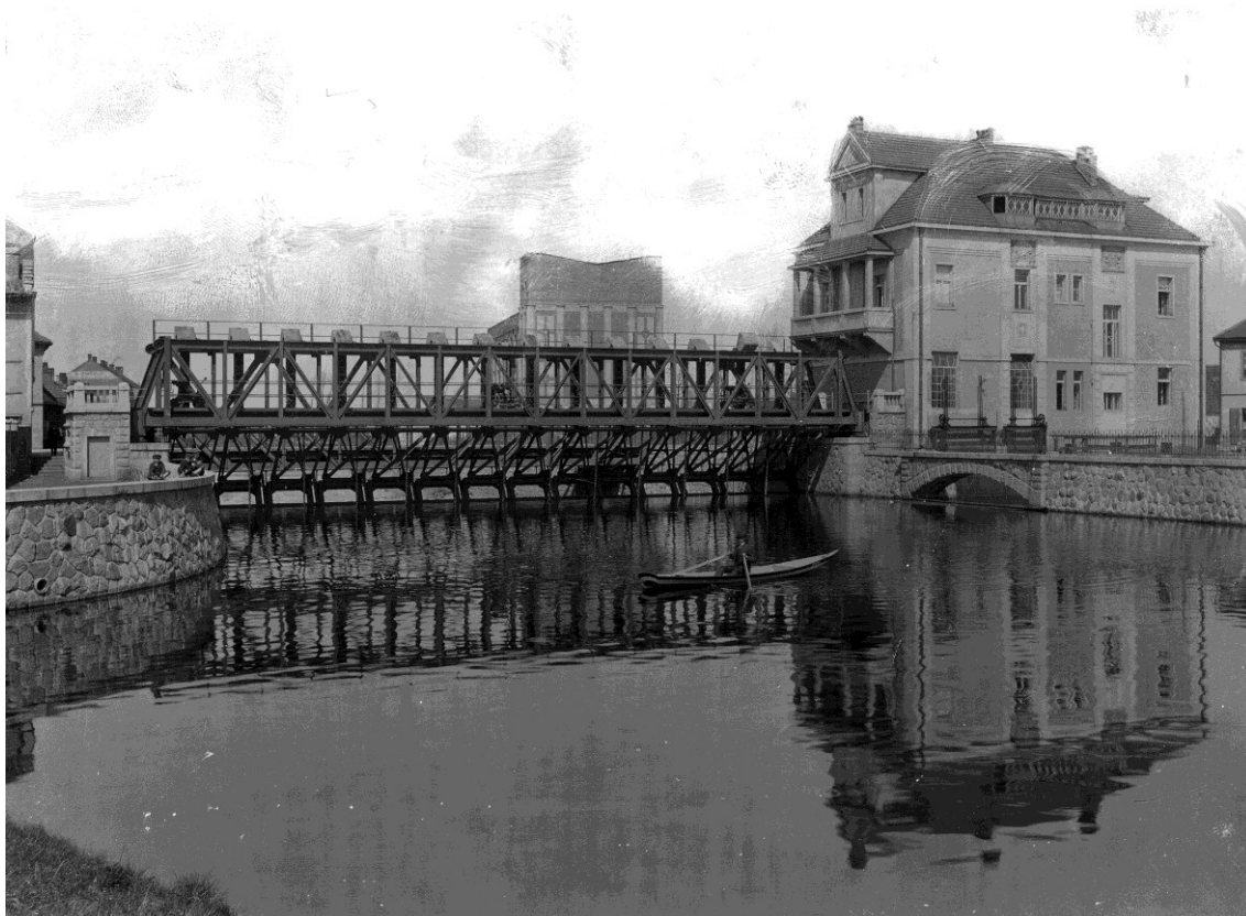
4. Hydroelektrárna na Chrudimce, vzadu uprostřed mlýn Bratři Winternitzové, bez datace
