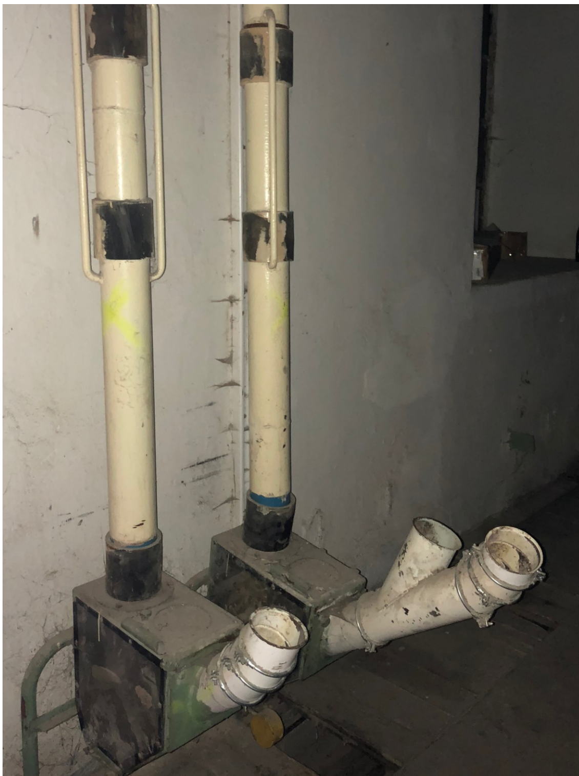
10. Kovové moukovody, současný stav
