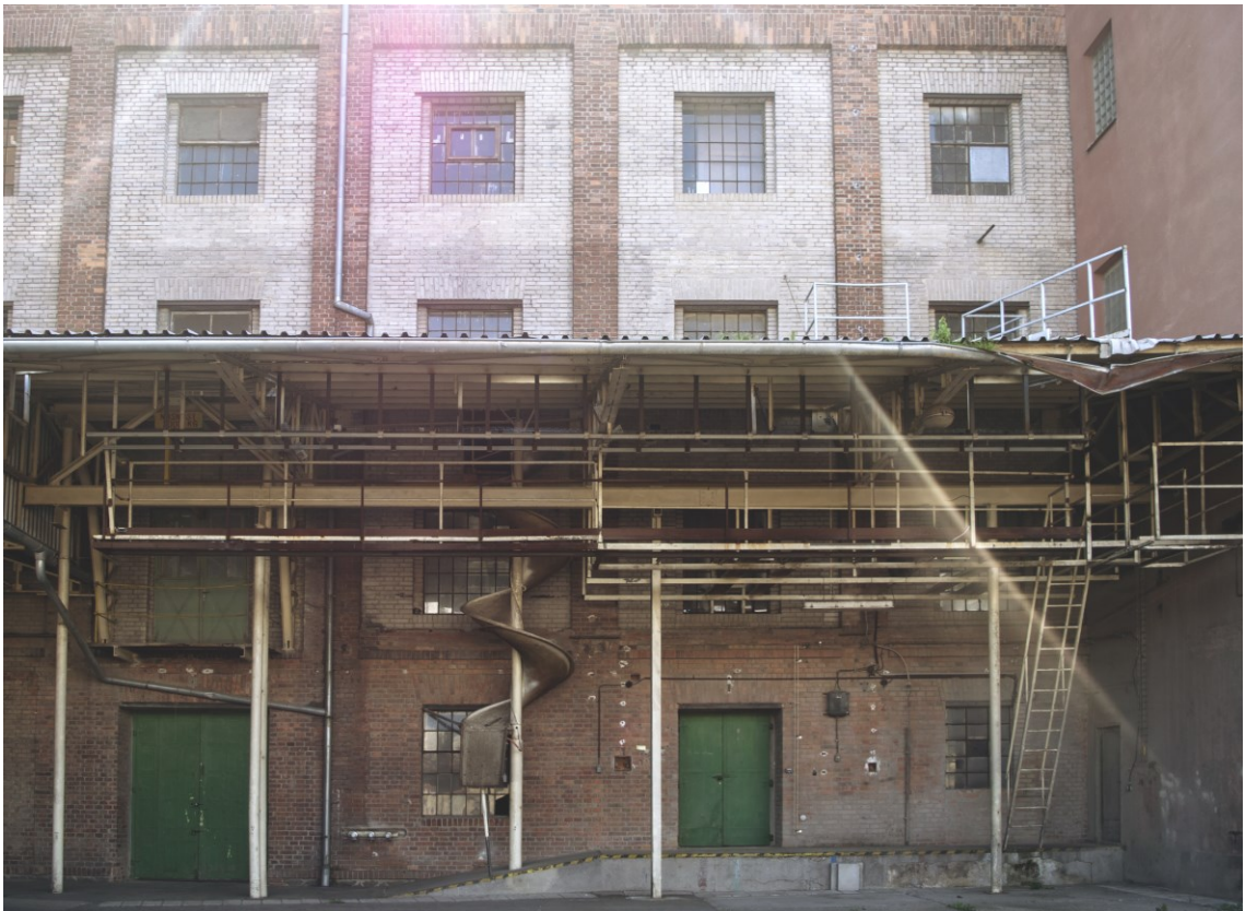
35. Pohled na východní průčelí budovy z roku 1911, současný stav
