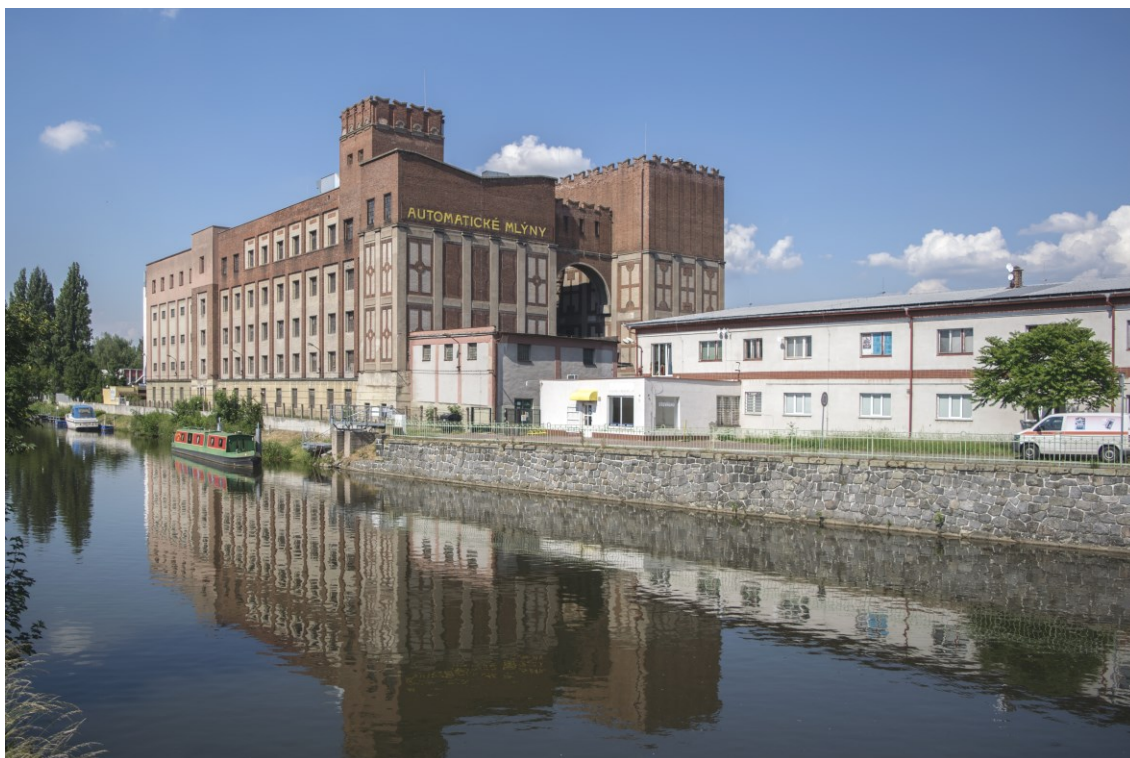
28. Pohled na areál od Chrudimky, současný stav
