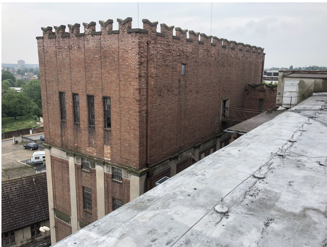
26. Východní silo při pohledu ze střechy, současný stav
