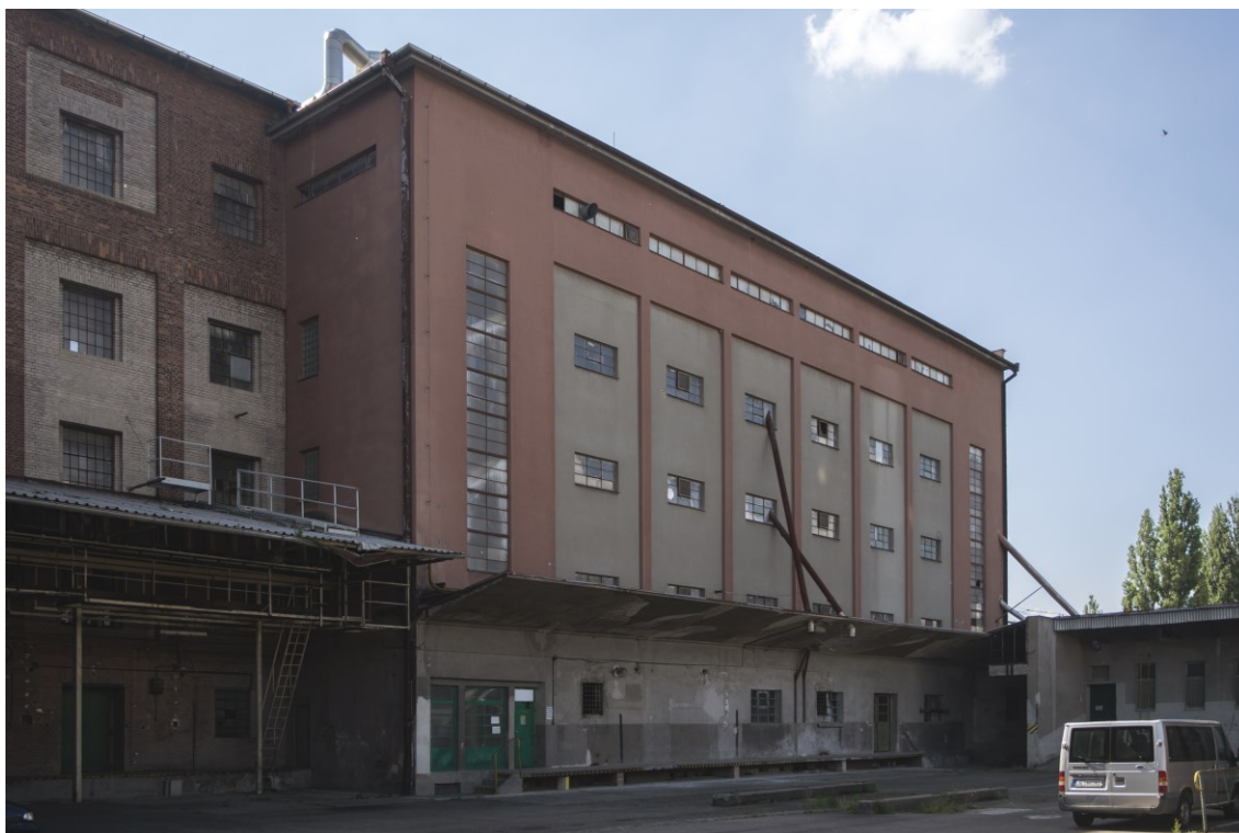
36. Pohled na východní průčelí přístavby z šedesátých let, současný stav
