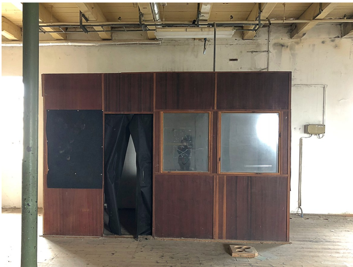
17. Rídící kabina, současný stav
