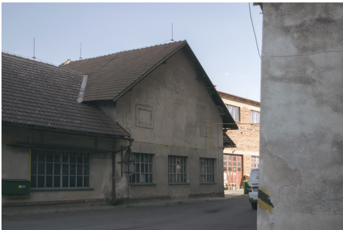
39. Původní hospodářská budova z roku 1911, současný stav
