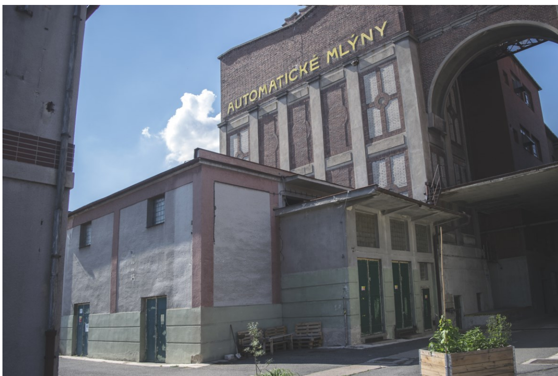
31. Pohled na trafostanici v místě původního turbínového domku, detail jižního průčelí budovy z roku 1911, současný stav
