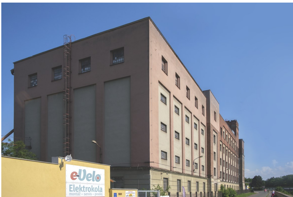
37. Pohled na severní a západní průčelí, současný stav
