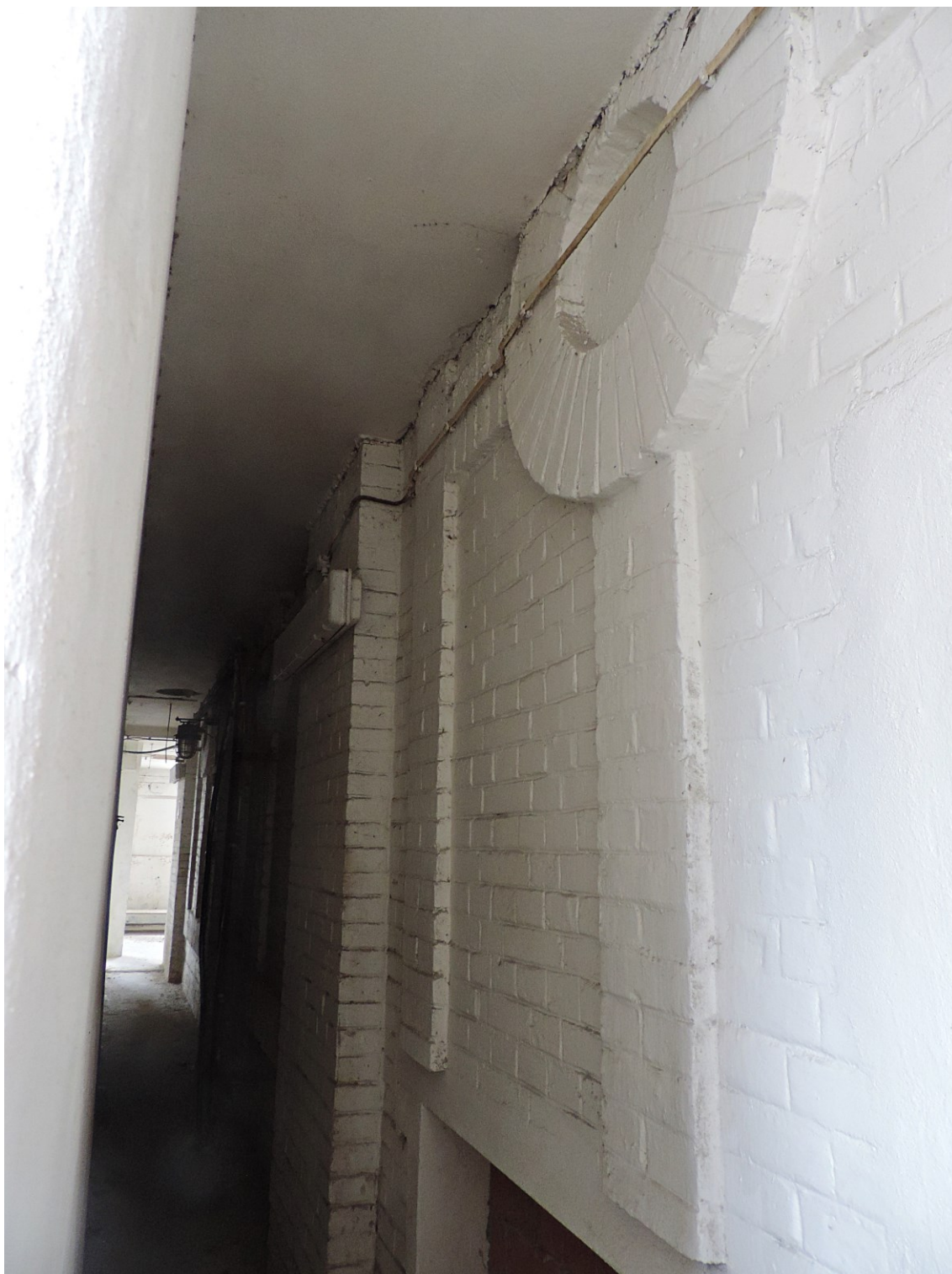
20. Detail severního průčelí budovy z roku 1911, současný stav
