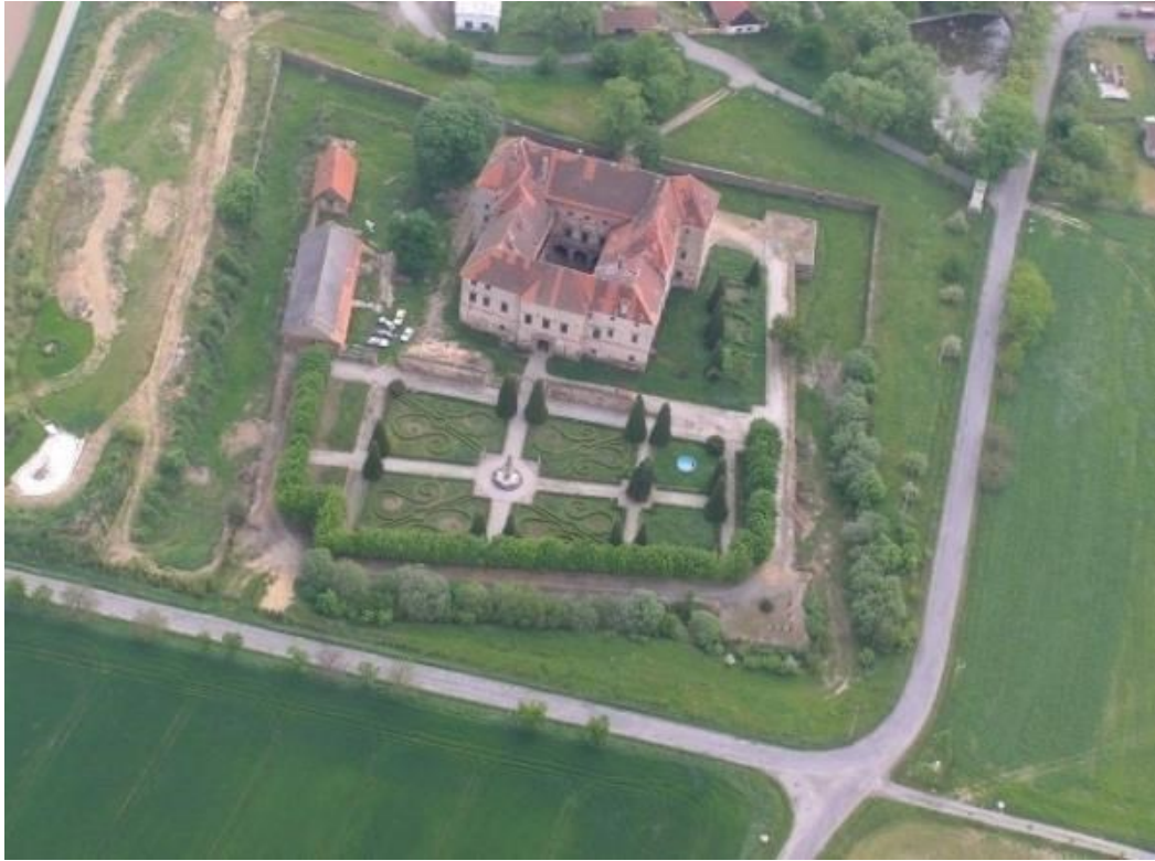
29. Kaceřov, zámecký areál, letecký pohled
