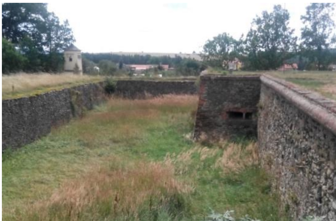
44. Kaceřov, východní část opevnění, jihovýchodní bastion
