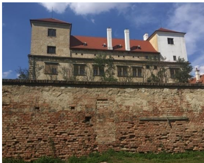
60. Bučovice, opevnění, část obranné zdi
