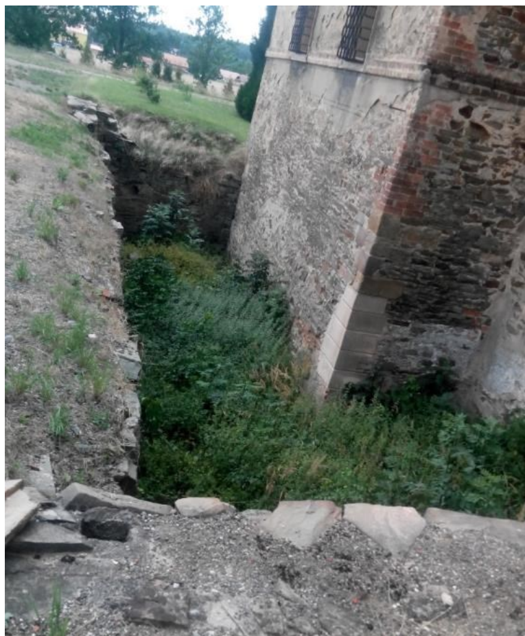
43. Kaceřov, detail příkopu u vstupního portálu
