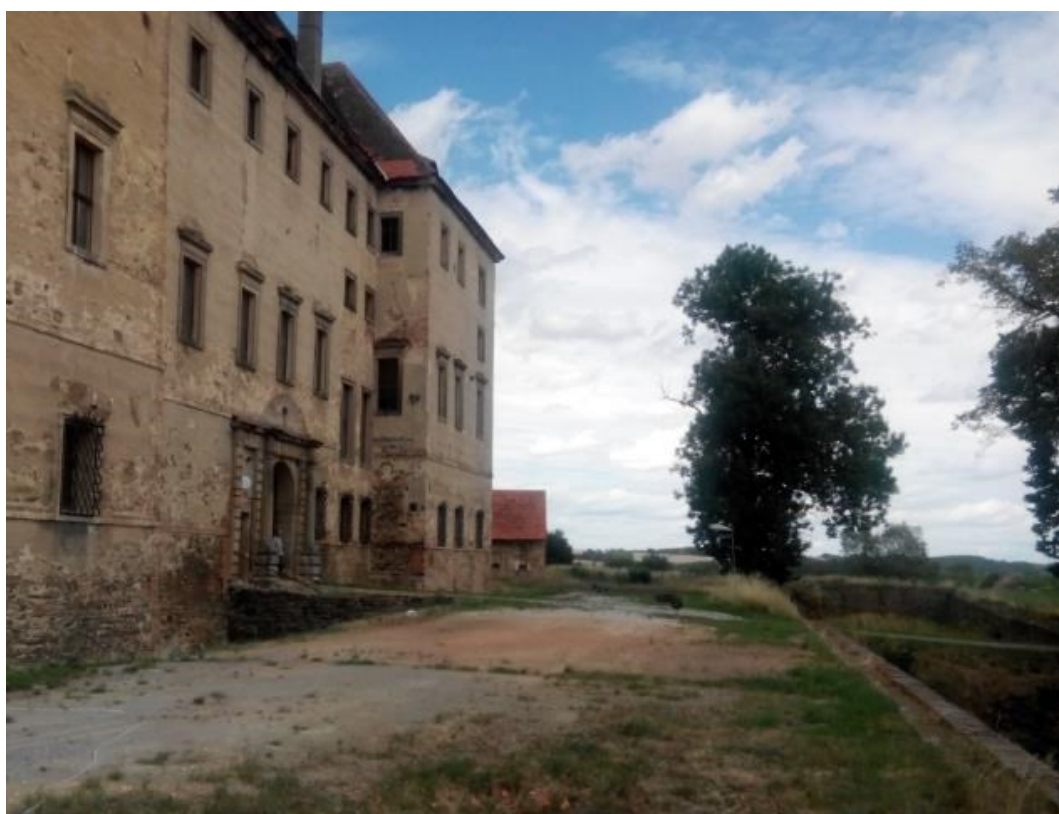
42. Kaceřov, hlavní průčelí, přístupová cesta
