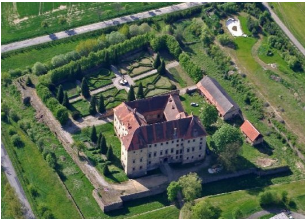
28. Kaceřov, zámecký areál, letecký pohled
