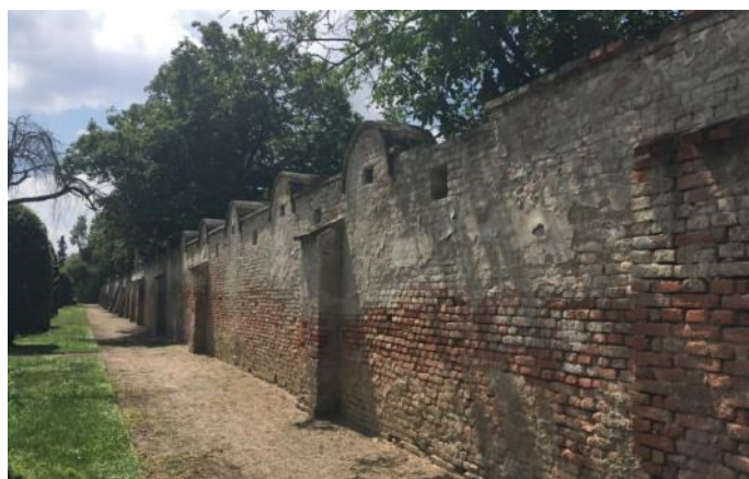
62. Bučovice, opevnění, část obranné zdi
