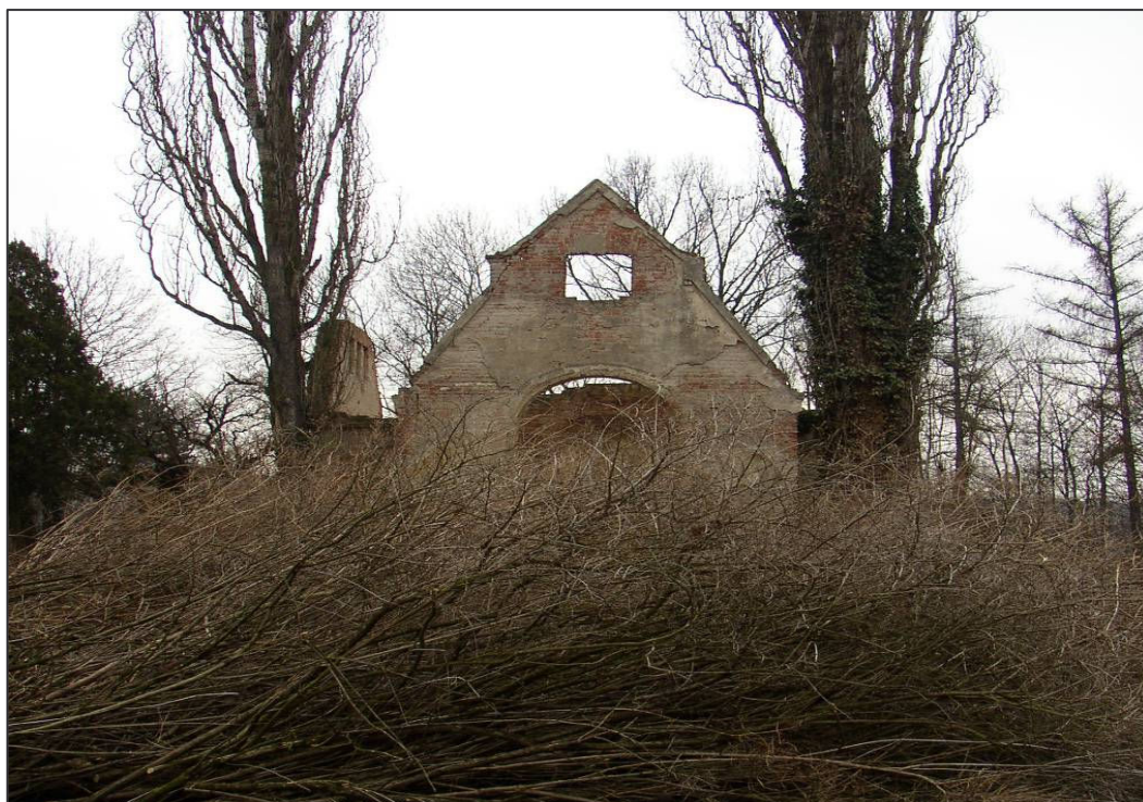
Foto č. 6: Bohnice – ústavní hřbitov – vyhořelá kaple
