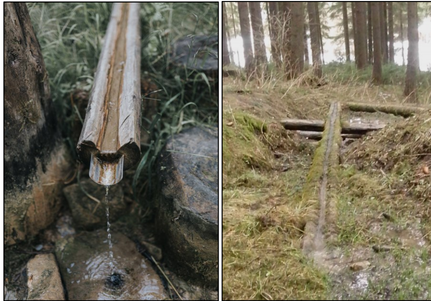
Obrázok 9: Studnička v dobrom stave s prietokom a zanesená, chátrajúca studnička, Kysuce. Zdroj: fotografie autorky.
