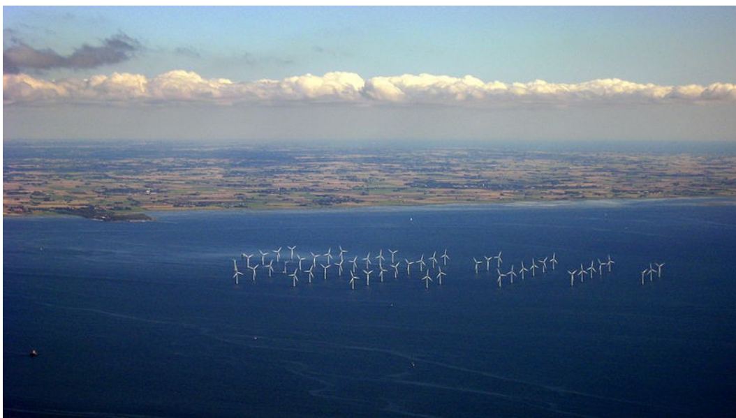
Obr. č. 11 – Pobřežní větrná elektrárna Lillgrund. Foto: Tomasz Sienicki. Licence: CC by 3.0.
