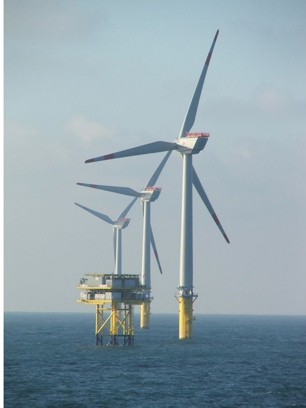
Obr. č. 10 – Větrné turbíny a elektrická rozvodna větrné elektrárny Alpha Ventus v severním moři. Licence: CC by SA – 3.0. Foto: SteKrueBe na Wikipedii.
