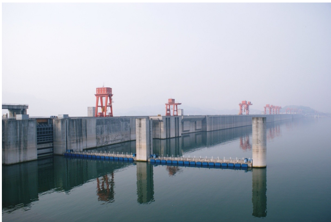
Obr. č. 9 – Druhá nejvýkonnější vodní elektrárna na světě. Three Gorges Dam v Číně. Kredit: Hugh Llewelyn. CC by 2.0.
