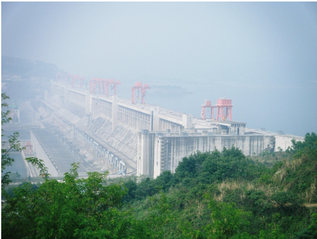
Obr. č. 8 – Druhá nejvýkonnější vodní elektrárna na světě. Three Gorges Dam v Číně. Kredit: Hugh Llewelyn. CC by 2.0.
