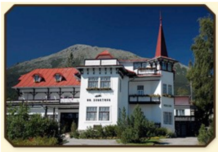
38 Nový Smokovec: Vila Dr. Szontagha, súčasný stav, autor neznámy
