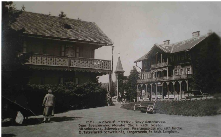
21 Starý Smokovec: Vľavo sa nachádza Švajčiarsky dom, vpravo hotel Morské oko, ktorý zanikol v 30. rokoch 20. storočia a v pozadí katolícky kostolík
