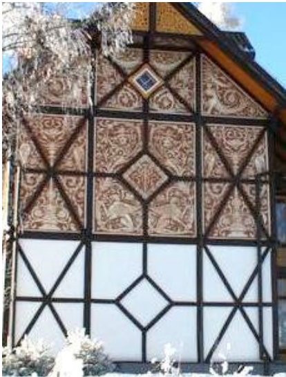
18 Dolný Smokovec: detail fasády hrazdených polí s neorenesančnou sgrafitovou výzdobou na vile Aesculan, Gedeon Majunke
