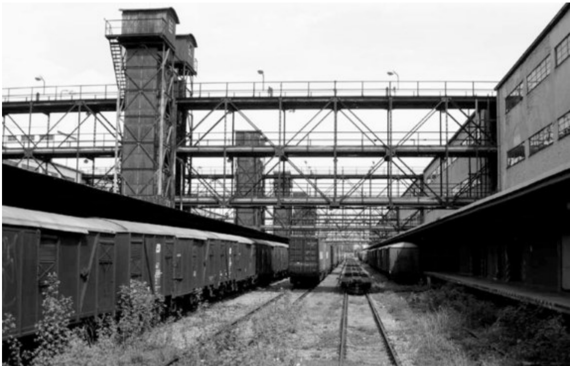
33. Nákladové nádraží Žižkov, střední rampa, výtahové věže a lávky
