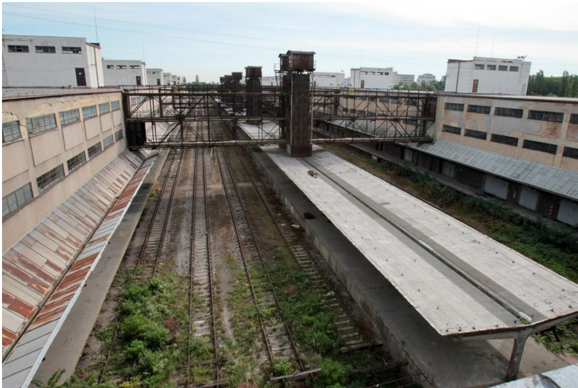
32. Nákladové nádraží Žižkov, boční křídla bývalých skladišť, střední rampa
