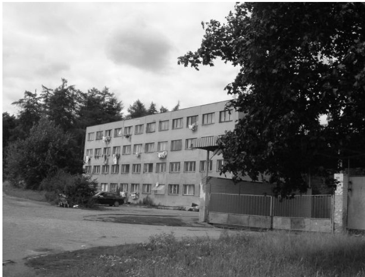
Panelový dům „U Masokombinátu“ Kladno, srpen 2006
