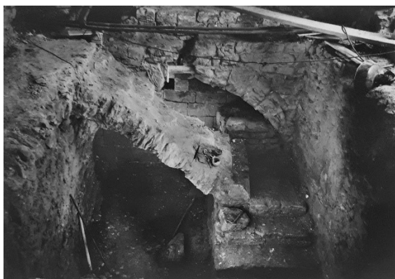
30. Pohled do výkopu v místnosti B, z chodby přízemí
