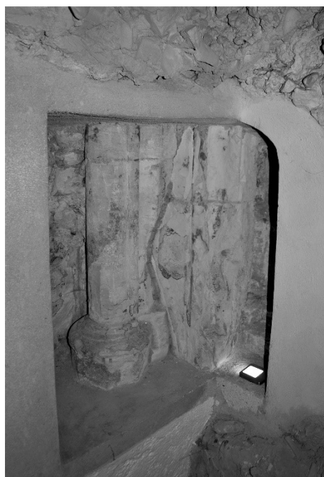
35. Relikty sedile v jižní části kněžiště, pohled z východu
