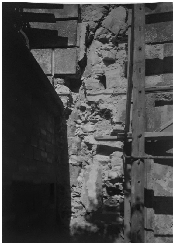
28. Celkový záběr sondy na východní fasádě rizalitu jižního křídla
