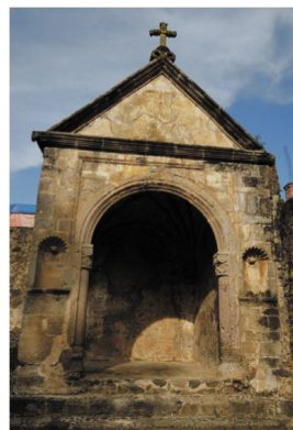
Druhá capilla posa umístěná na západní straně klášterního komplexu
