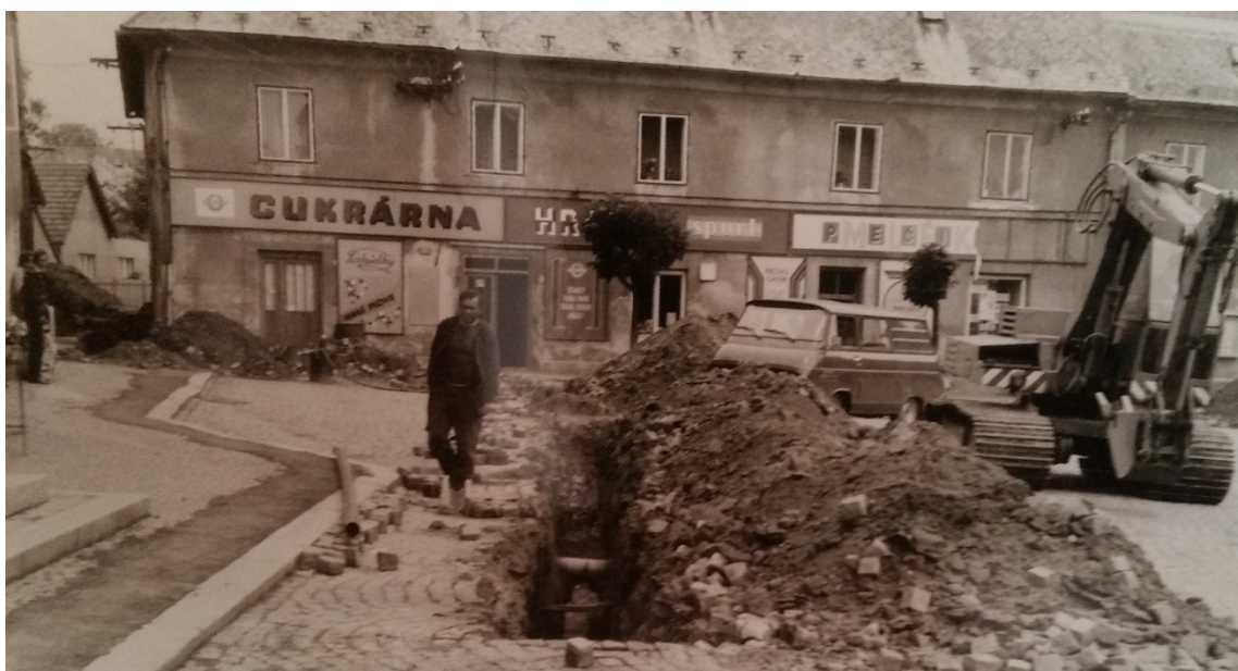
Obr. 12. výstavba vodovodu na haberském náměstí. V pozadí tehdejší cukrárna, prodejna hraček a sportovních potřeb a prodejna pečiva a mléka
