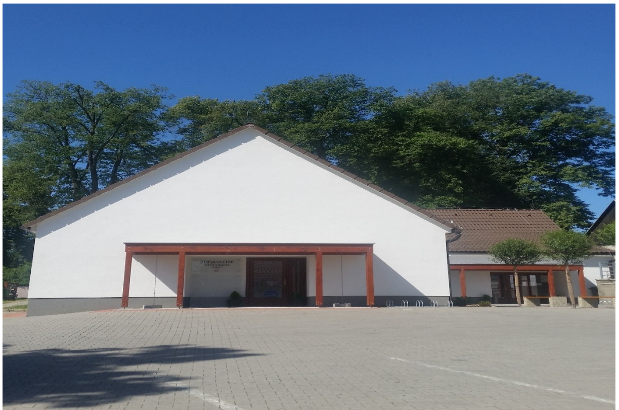
Obr. 30. Budova zaniklé prodejny Flop, přeměněná na Zdravotní středisko s prostory pro komunitní centrum.
