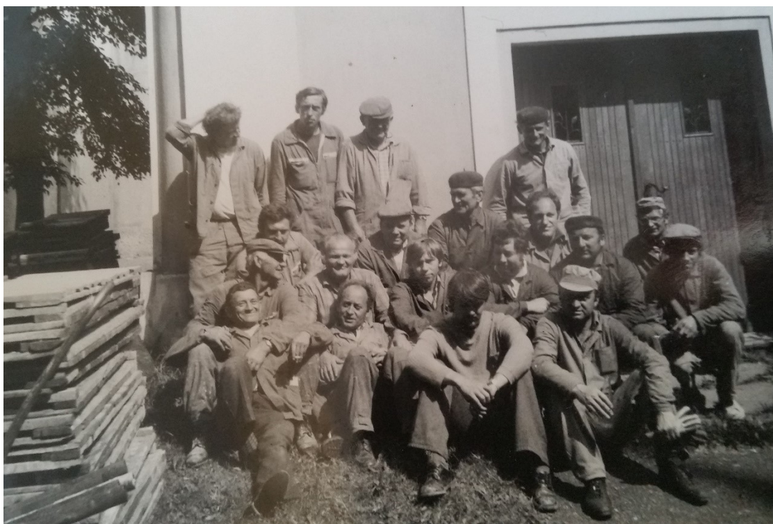
Obr. 10. opravy kostela v roce 1982 probíhaly formou dobrovolných brigád.
