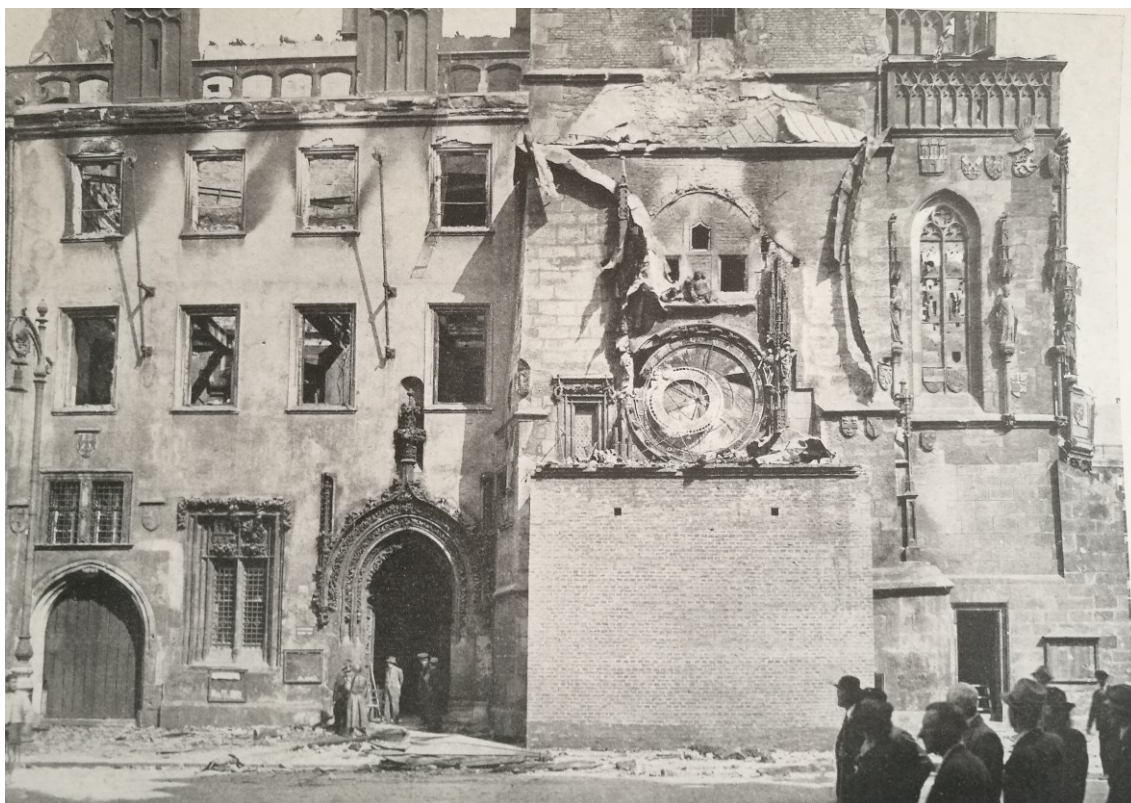
14. Staroměstská radnice v květnu 1945. Zničený orloj a část jižního průčelí.
