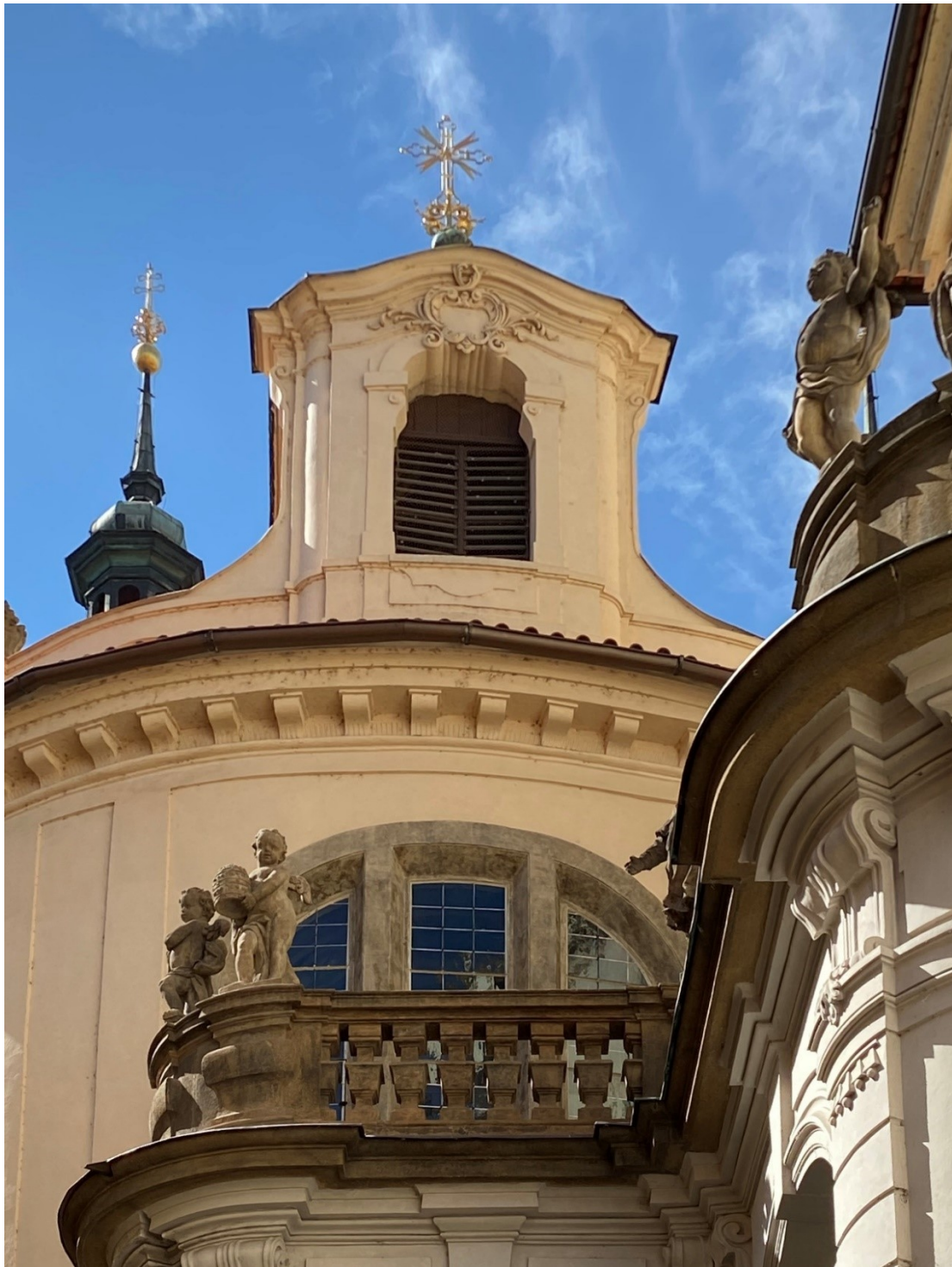
11. Vlašská kaple, Praha, 1590, vikýřová věž s atikou a balustrádou vstupního portiku
