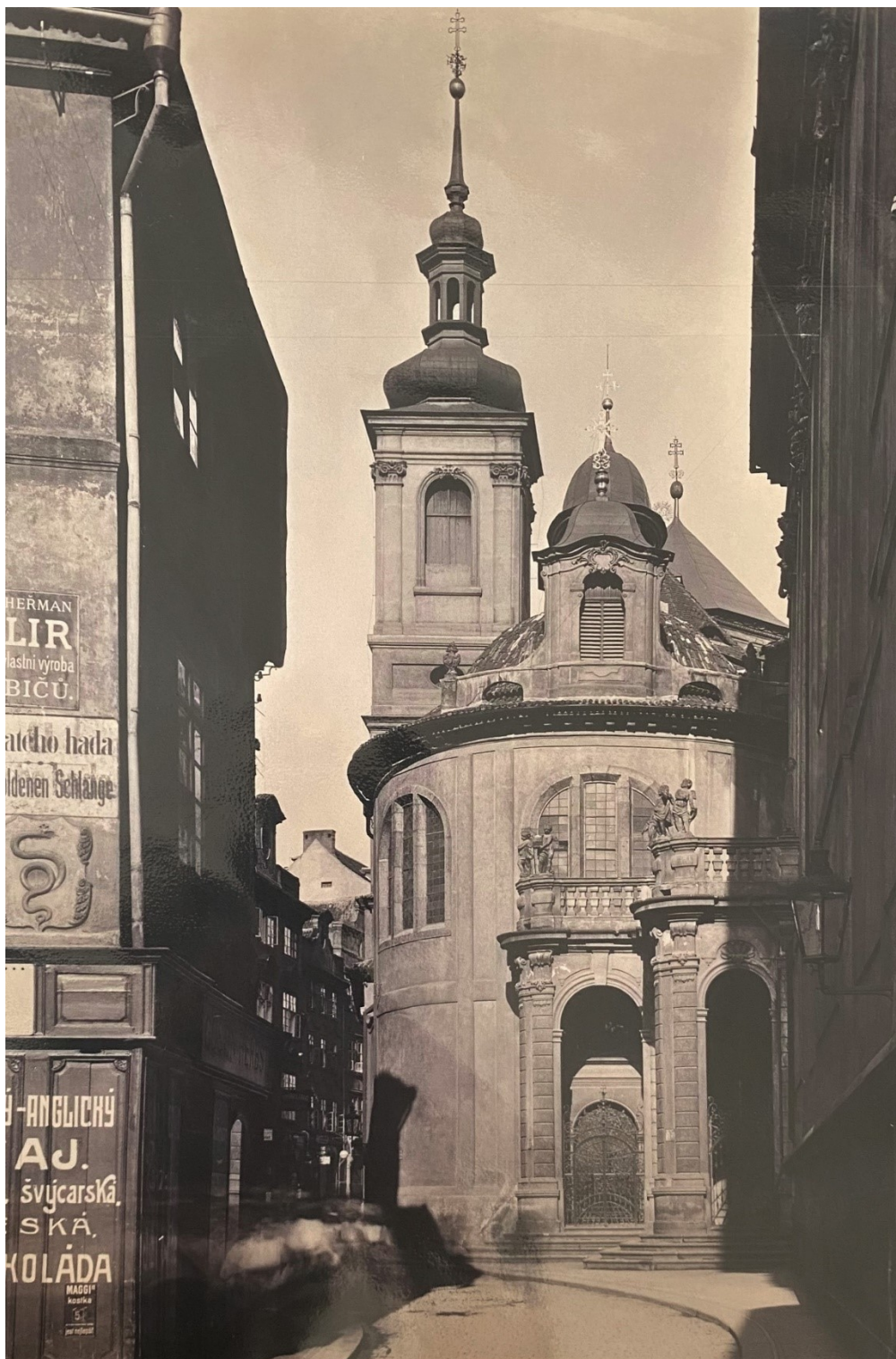
9. Vlašská kaple, Praha, 1590, pohled z východní strany na hlavní vstup s portikem. Snímek A. Paul, archiv NPÚ
