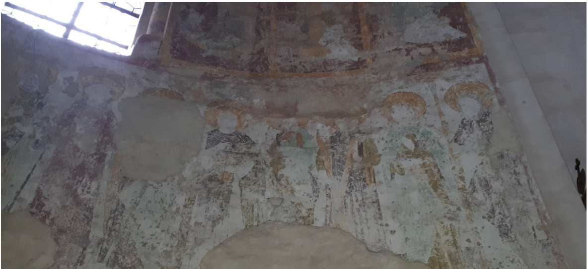
8. Potvorov, kostel sv. Mikuláše, kol. r. 1240, část výzdoby apsidy
