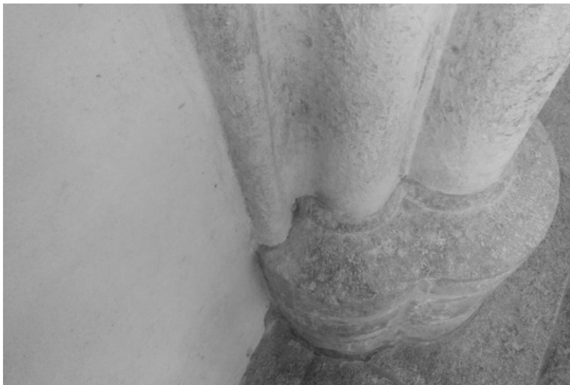
18) Kostel sv. Bartoloměje v Kolíně nad Labem, patková část svazkové přípory, foto: Filip Facincani
