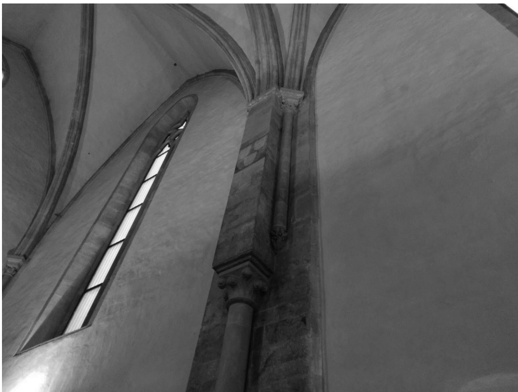
20) Svatyně Nejsv. Salvátora, severní uspořádání přípor mezi klenebními poli podélné části, foto: Filip Facincani
