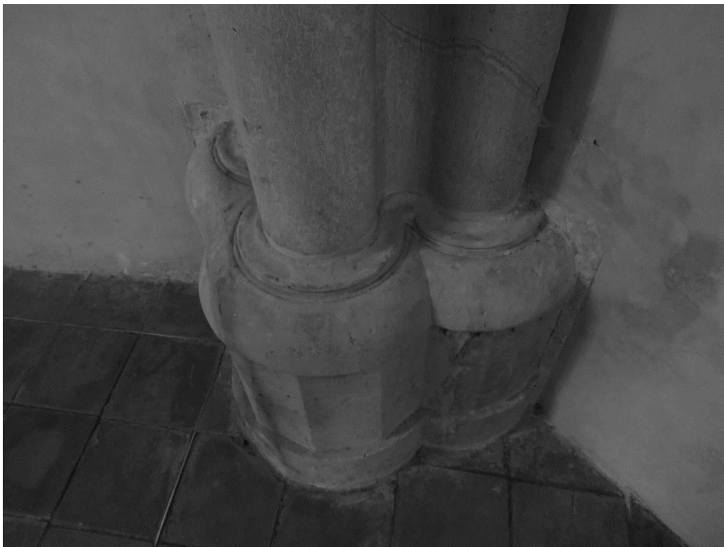
19) Svatyně Nejsv. Salvátora, patková část svazkové přípory presbyteria, foto: Filip Facincani
