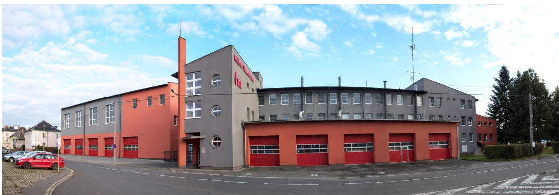
Obrázek č. 6 – Hasičská stanice Opava
