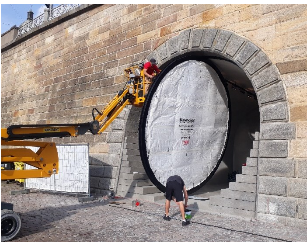
Obr. 17: Rekonstrukce kobek – natírání obvodu okenního skla 10. 9. 2019. Foto: autor.
