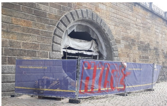
Obr. 15: Rekonstrukce kobek začaly. Oplocení okolo nich omezuje pohyb po ploše náplavky (duben 2019). Foto: autor.
