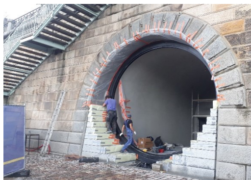
Obr. 16: Probíhající rekonstrukce kobek (srpen 2019). Foto: autor.
