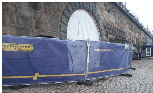
Obr. 14: Kobky před rekonstrukcí potaženy bílou plachtou. Černé úchyty budoucích oken připraveny za oplocením (prosinec 2019). Foto: autor.
