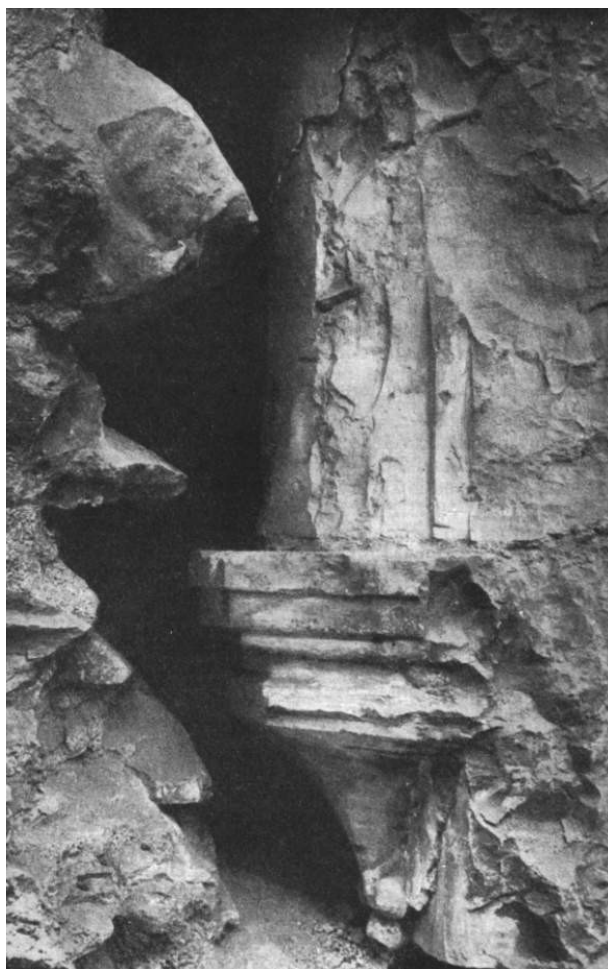
Obr. iv 8. Praha, bývalý klášter božehrobců Na Zderaze. Odhalená konzola pasu arkády ambitu v domě čp. 275/II v letech 1954–1955. Podle Píša 1957.
