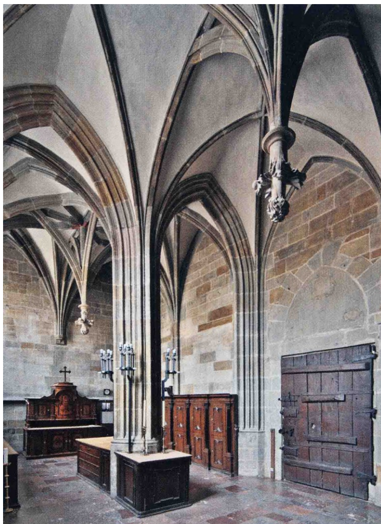
Obr. vii 8. Praha, katedrála sv. Víta, přízemí severní sakristie s vysutými žebry a zavěšeným svorníkem. Podle Maříková-Kubková 2019a, s. 150 (Jan Gloc).
