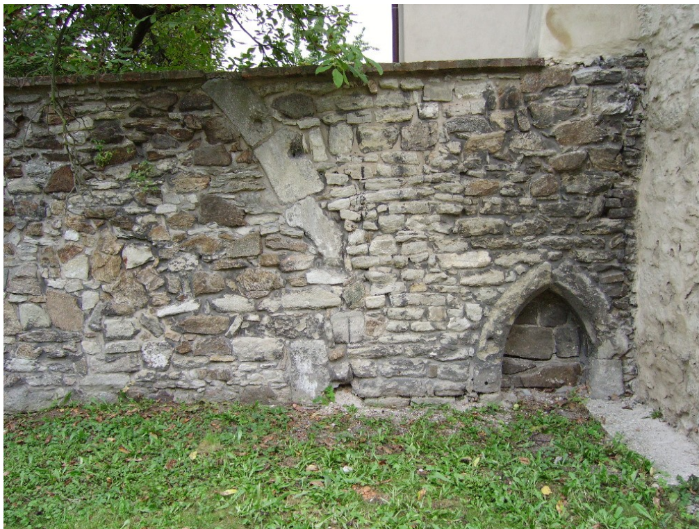
Obr. ix 6. Sedlec, cisterciácký klášter, kostel sv. Filipa a Jakuba. Pozůstatek jižní zdi jižní lodi se zazděnou arkádou do bývalé kaple sv. Ondřeje/Božího Těla. Snímek z roku 2008.
