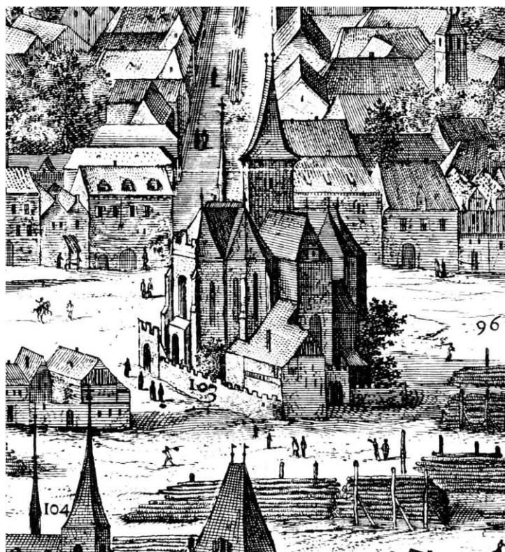
Obr. vii 3. Praha, kaple Božího Těla na Karlově náměstí, pohled od severozápadu. Philipp van den Bossche – Johannes Wechter – Egidius Sadeler, pohled na Prahu, 1606, detail.
