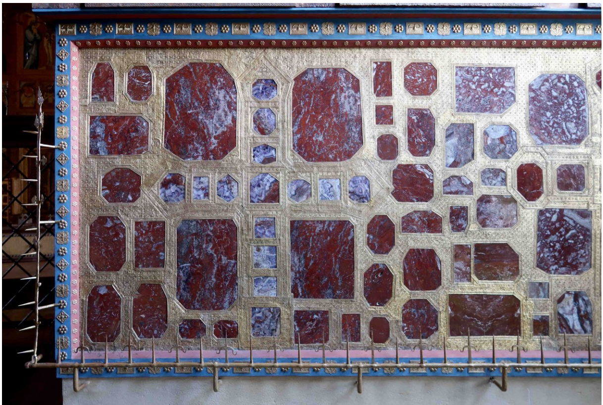
Obr. v 18. Karlštejn, větší věž, kaple sv. Kříže (původně druhá kaple Umučení a jejich Nástrojů). Detail obložení. Foto Petr Uličný.
