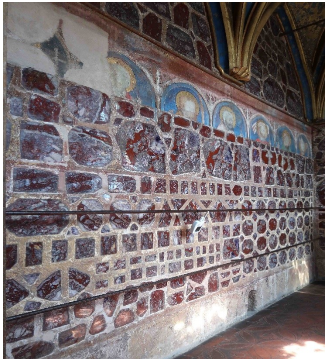
Obr. v 9. Karlštejn, menší věž, kaple sv. Kateřiny (původně kaple Umučení a jejich Nástrojů). Detail stěny s polodrahokamovým obkladem. Foto Petr Uličný.
