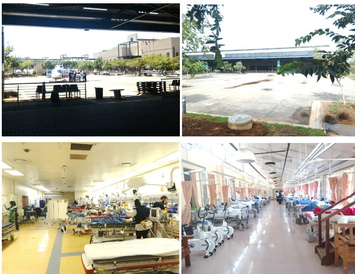
Obr. 16: Nemocnice Chris Hani Baragwanath, Johannesburg 2015: a, b) heliport s rozsáhlým zastřešeným prostorem pro třídění pacientů, c) centrální místnost akutního příjmu s 12 ventilovanými lůžky, kde se provádějí i urgentní, život zachraňující výkony, d) lůžkové oddělení - v popředí pomůcky na časnou rehabilitaci (foto archiv autora).
