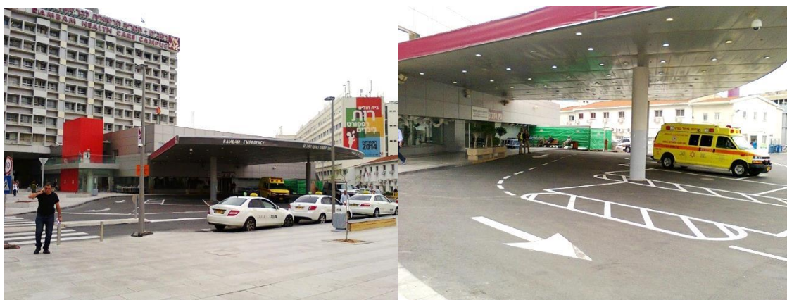
Obr. 17: Rambam Health Care Campus v Haifě 2014: a) vjezd na oddělení akutního příjmu, b) krytý vstup s jednosměrným provozem je možno v případě potřeby použít i jako prostor pro triage ( foto archiv autora).
