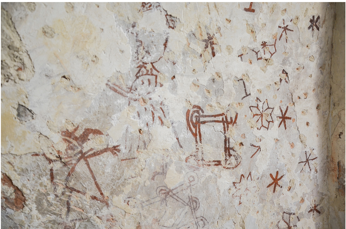
Obr. 3 Kuřívody, kostel sv. Havla. Neobvyklé malby s figurálními i geometrickými motivy na středověkých omítkách na klenbě, provedené červenou barvou. Foto: Ivona Kociánová.
