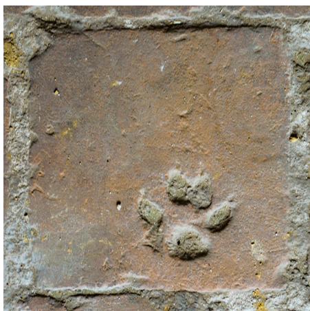
Obr. 30 Litomyšl, zámek. Prostor mezi- patra. Otisk zvířecí tlapky v cihelné podlaze, vzniklý ještě před výpalem.
