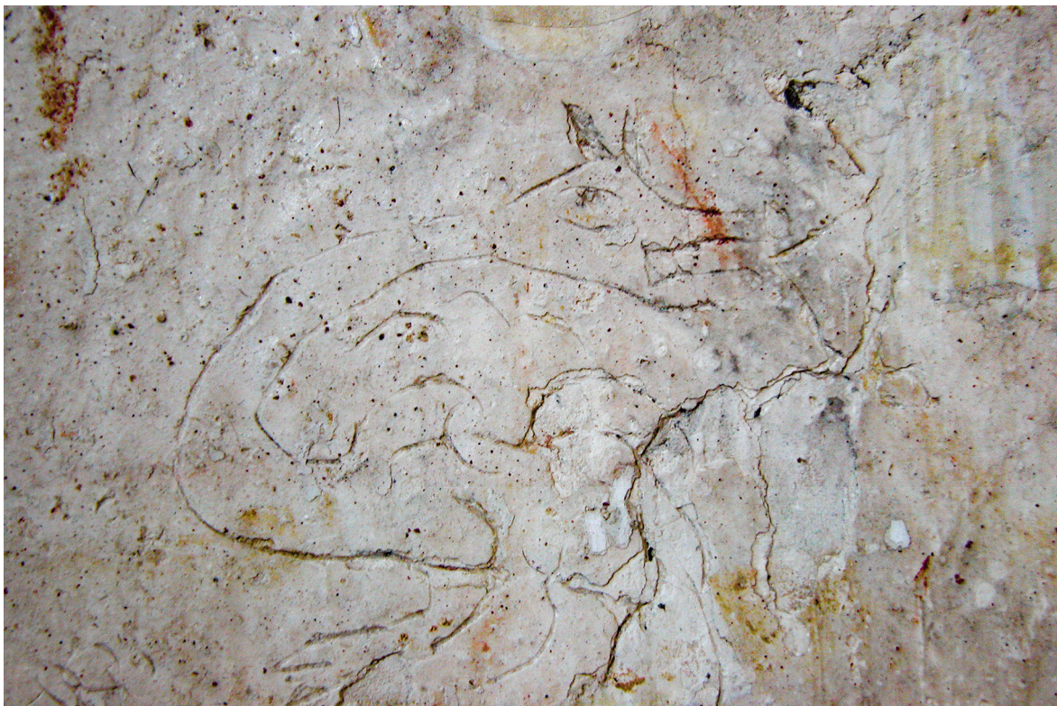
Obr. 77 Velká Lomnice, kostel sv. Kateřiny Alexandrijské. Kresba bájného stvoření (snad draka) vyrytá do středověké omítkové vrstvy s vápenným nátěrem. Foto: Filip Menzel.
