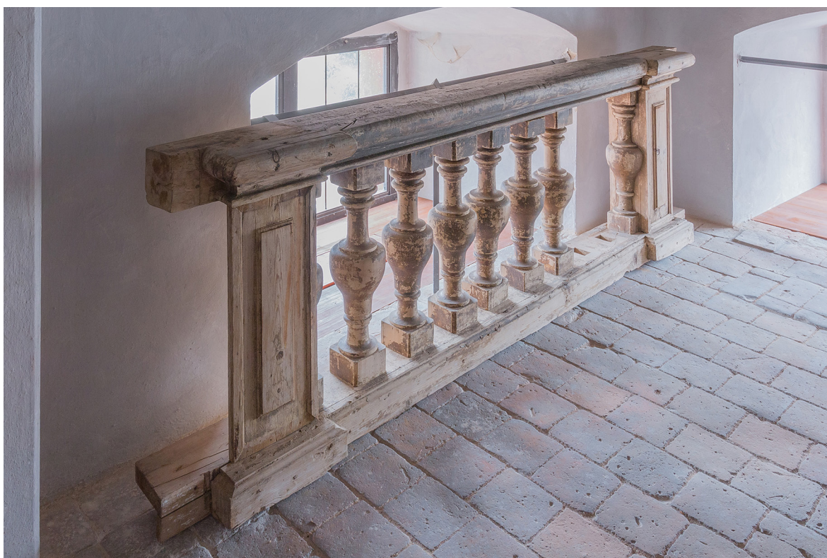
Obr. 135 Piaristický chrám, místnost pod severní věží, sousedící s kruchtou. Sekundárně umístěné balustrové zábradlí z empory s dochovaným epigrafickým souborem. Foto: Vojtěch Krajíček.
