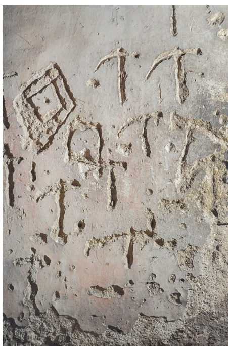
Obr. 49 Pardubice, zámek, prostor krovu. Tesařská kladívka vysekaná do štítové stěny.
