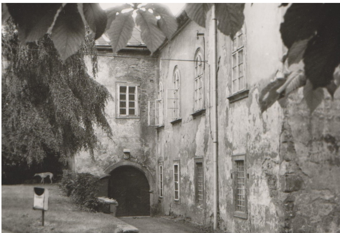
Obr. 90 Piaristická kolej v Litomyšli v 90. letech 20. století. Foto: Dana Schleichertová.
