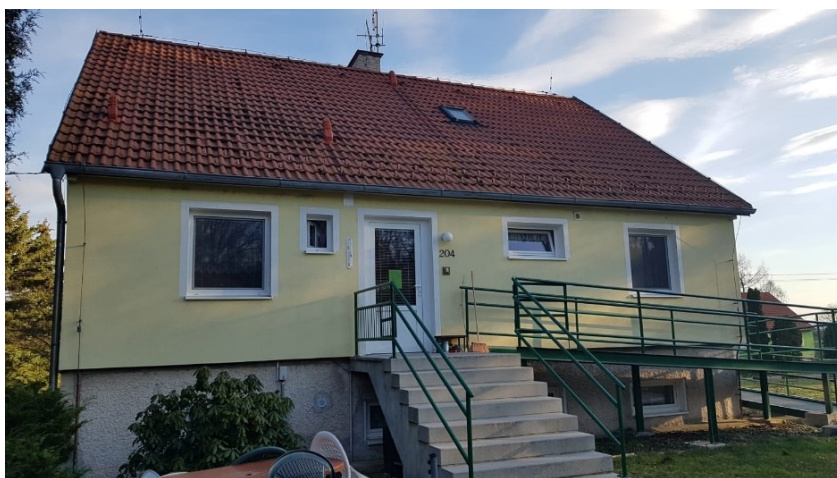
Příloha č. 3 – Okál – přední vchod. Foto Denisa Sadová, 2021
