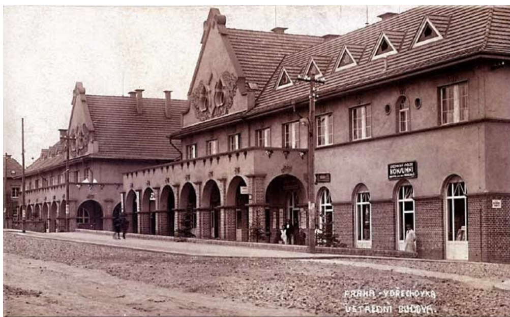
70. Jaroslav Vondrák, ústřední budova čp. 250 na Ořechovce, 1920–1923, Praha - Sřešovice
