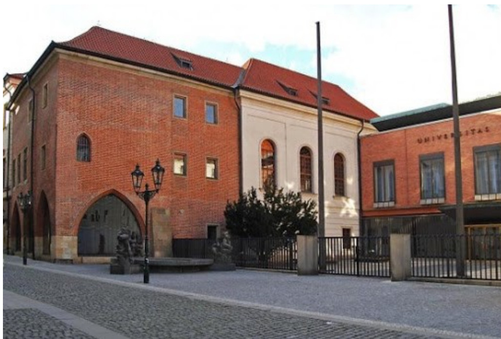
6. Karolinum , jižní průčelí historické části budovy a čestné nádvoří, Praha – Staré Město
