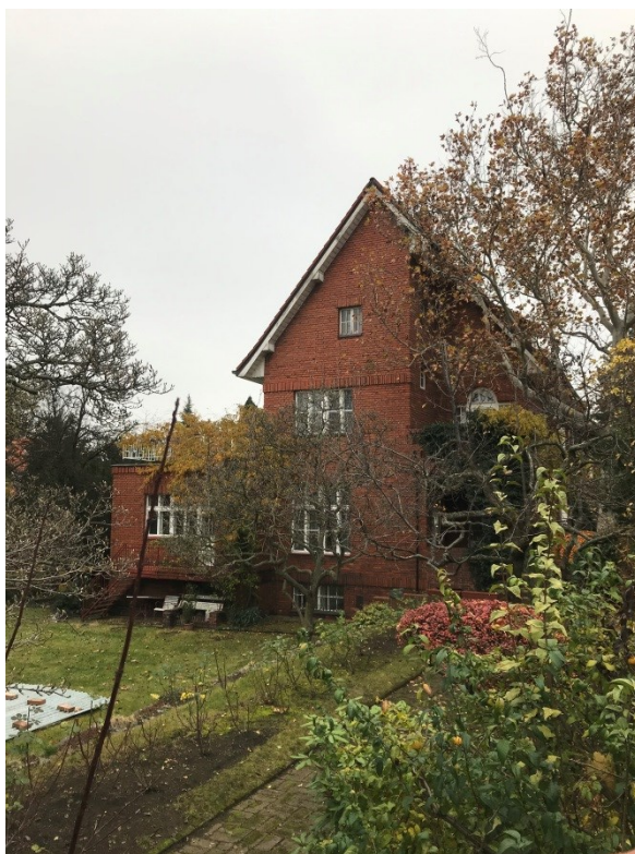
76. Pavel Janák , rodinný dům Vincence Beneše čp. 492/XVIII, 1923–1924, Cukrovarnická 24, Praha - Střešovice
