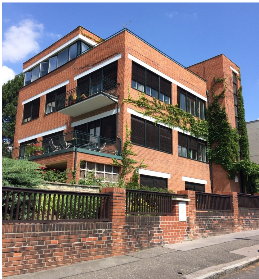
118. Karel Štipl , rodinný bytový dům, 1932–1933, pohled na jižní fasádu
