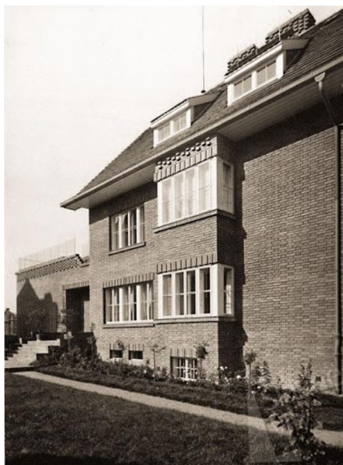
92. Pavel Janák, rodinný dům s ateliérem Bohumila Kafky, 1923–1924, jižní fasáda směřující do zahrady
