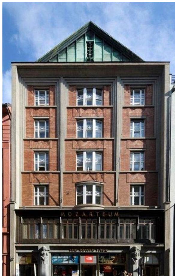
59. Jan Kotěra, Urbánkův dům, 1911–1913, Praha – Nové Město
