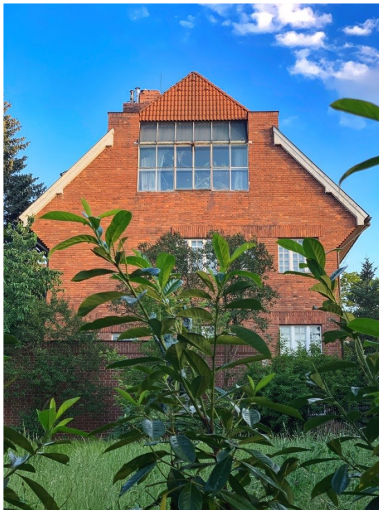
87. Pavel Janák , dvojdům Emila Filly a Františka Krejčího, 1923–1924, pohled na část domu Emila Filly s ateliérovým oknem v podkroví
