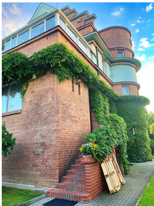
74. Jaroslav Vondrák, vlastní rodinný dům, 1923–1924, vchod do ateliéru a kanceláře architekta
