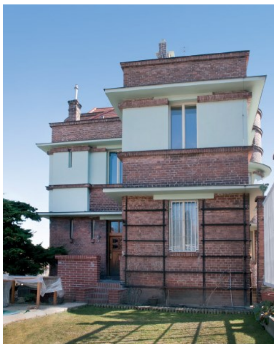
75. Jaroslav Vondrák, vlastní rodinný dům, 1923–1924, hlavní vchod do domu přístupný ze zahrady
