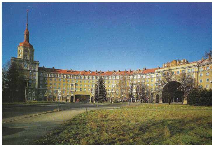
61. Ostrava – Poruba, E. Šteflíček, soubor obytných domů zvaných Oblouk, současná podoba
