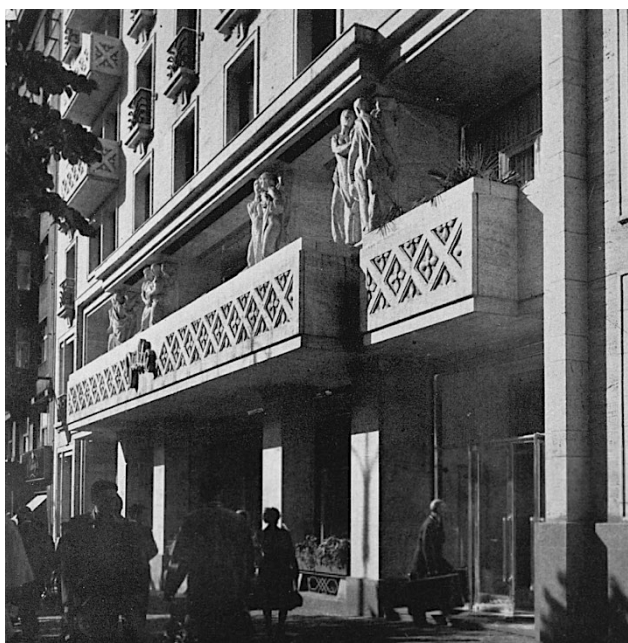
42. Praha, Hotel Jalta, A. Tenzer, detail hlavního průčelí
