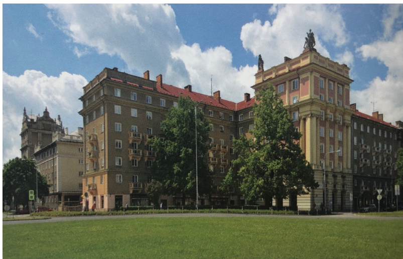
57. Ostrava – Poruba, B. Jelčaninov, obytné domy na Hlavní třídě, 1952 - 1955
