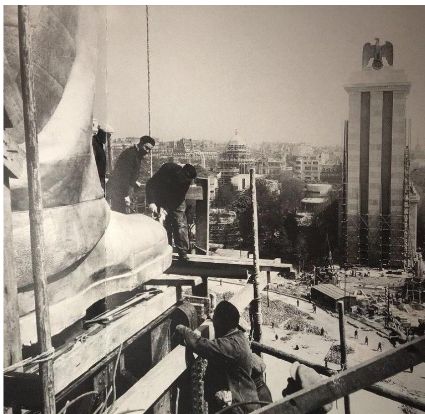
9. Výstavba pavilonu SSSR pro výstavu 1937
