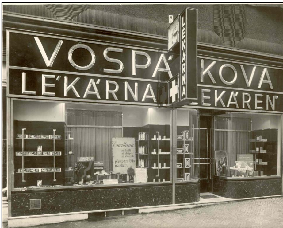
Obr. 21. Portál Vospálkovy lékárny, Praha II., Ječná ul. 1, 1934
