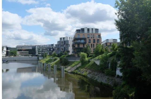
Zprivatizovaný břeh z protipovodňové hráze, Zdroj: Vlastní (2021)
