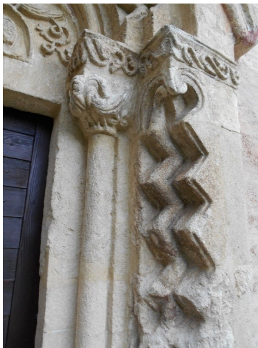
21c. Csempeszkopács, farní kostel, kolem polovina 13. století, hlavní portál-detail. Foto: autor
