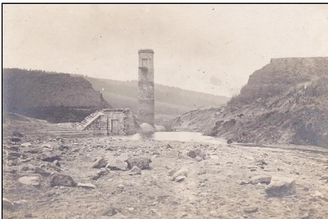
Obr. Č. 13.: Historická fotografie zachycující přehradní hráz po protržení (1916).
