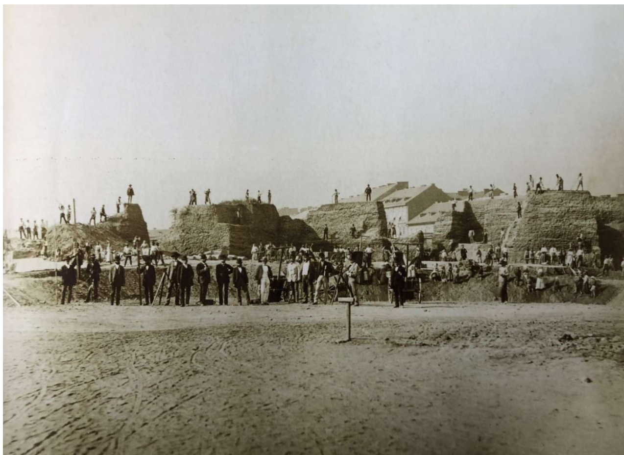
50. Boření hradeb v oblasti Nové brány na Novém Městě, kolem 1874, MMP inv. č. H 14.222
