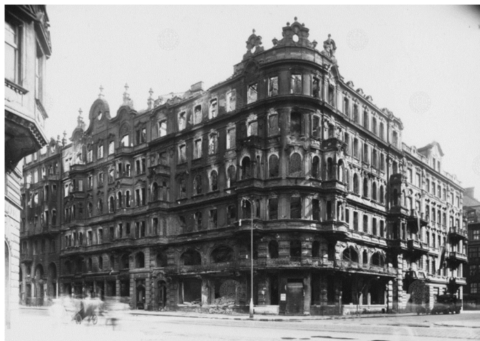
705. Dům čp. 199-V na nároží Pařížské a Bílkovy po válečném poškození, 1945, AMP A 17012
