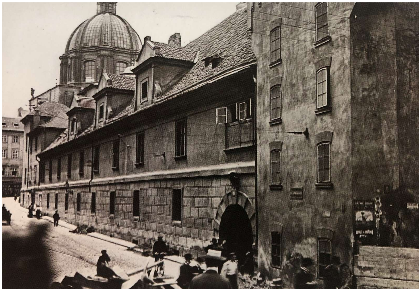
281. Historická budova Křížovnického kláštera čp. 191-I, před 1909, foto Jindřich Jaksch, NPÚ 10610
