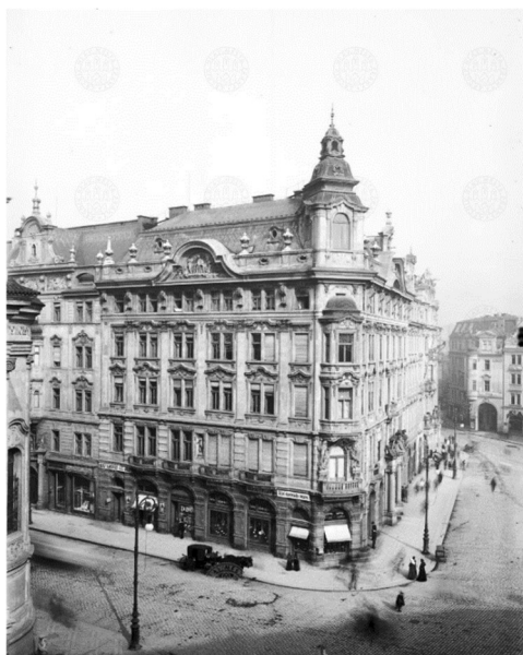
579. Schierův dům čp. 934-I na nároží Pařížské a Staroměstského náměstí, 1907, AMP XI 473
