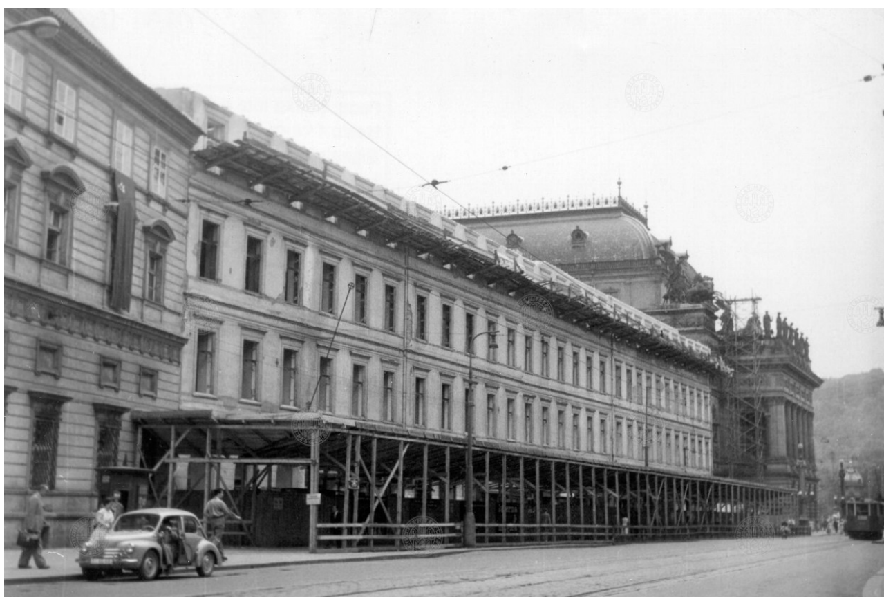
682. Kourovny domy čp. 1369-II a 1370-II na Národní třídě v průběhu demolice, 1959, foto Jiří Roleček, AMP I 50
