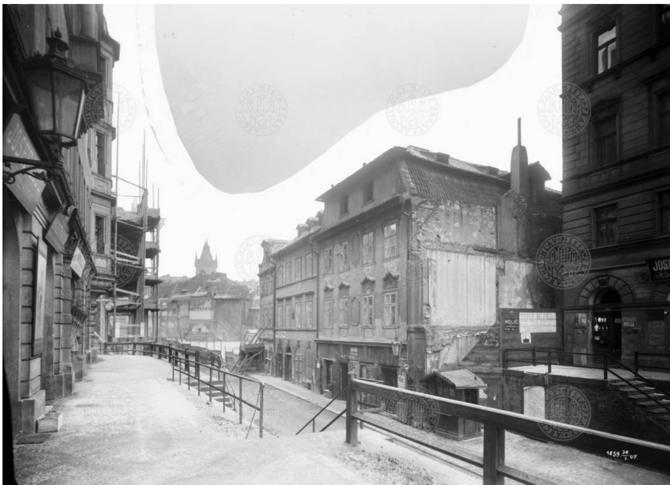
256. Průhled Karpovou ulicí k východu, 1907, foto Jindřich Eckert, AMP VIII 535
