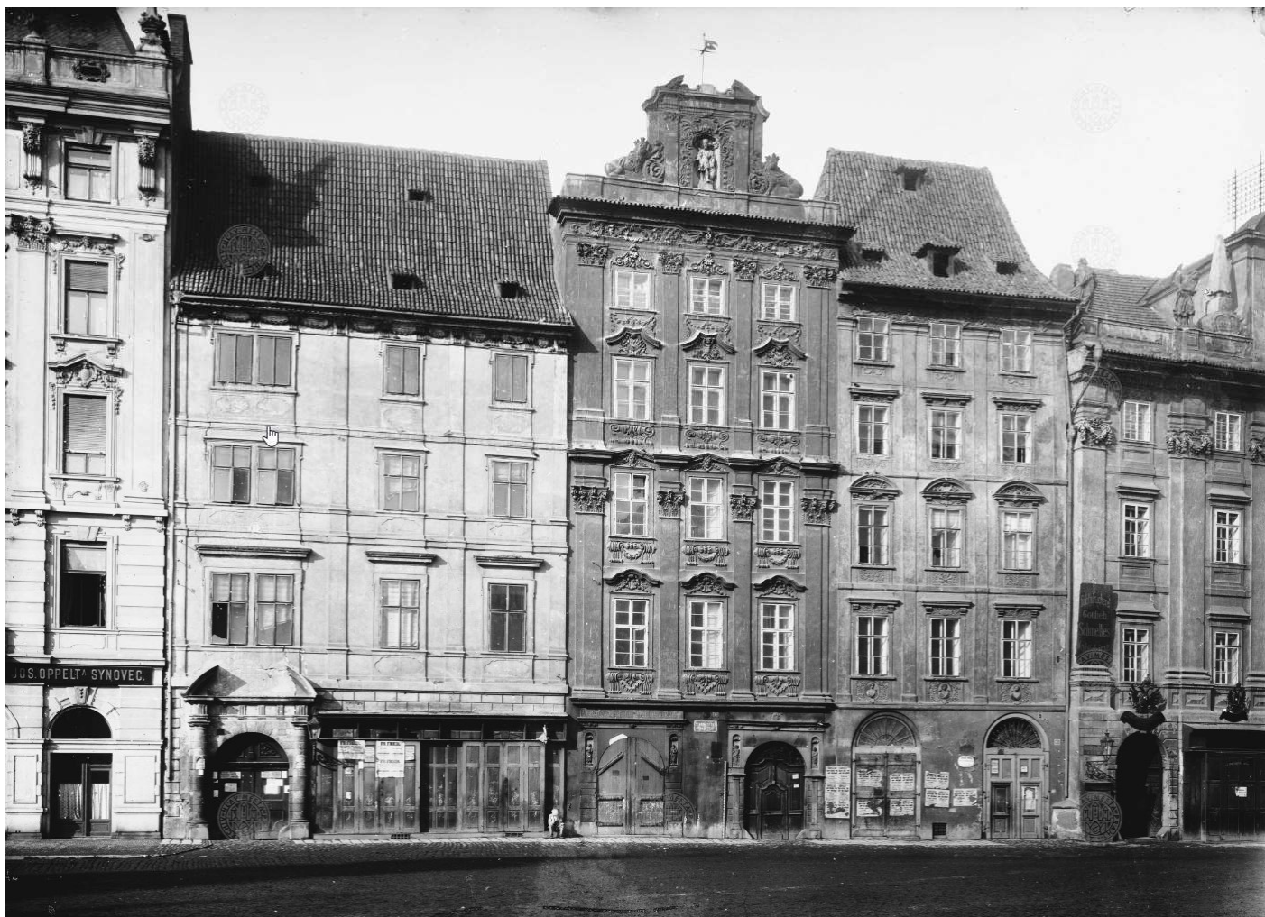
150. Domy čp. 933-I, 932-I a 930-I na severní straně Staroměstského náměstí před demolicí, 1898, foto Jindřich Eckert, AMP VIII 805
