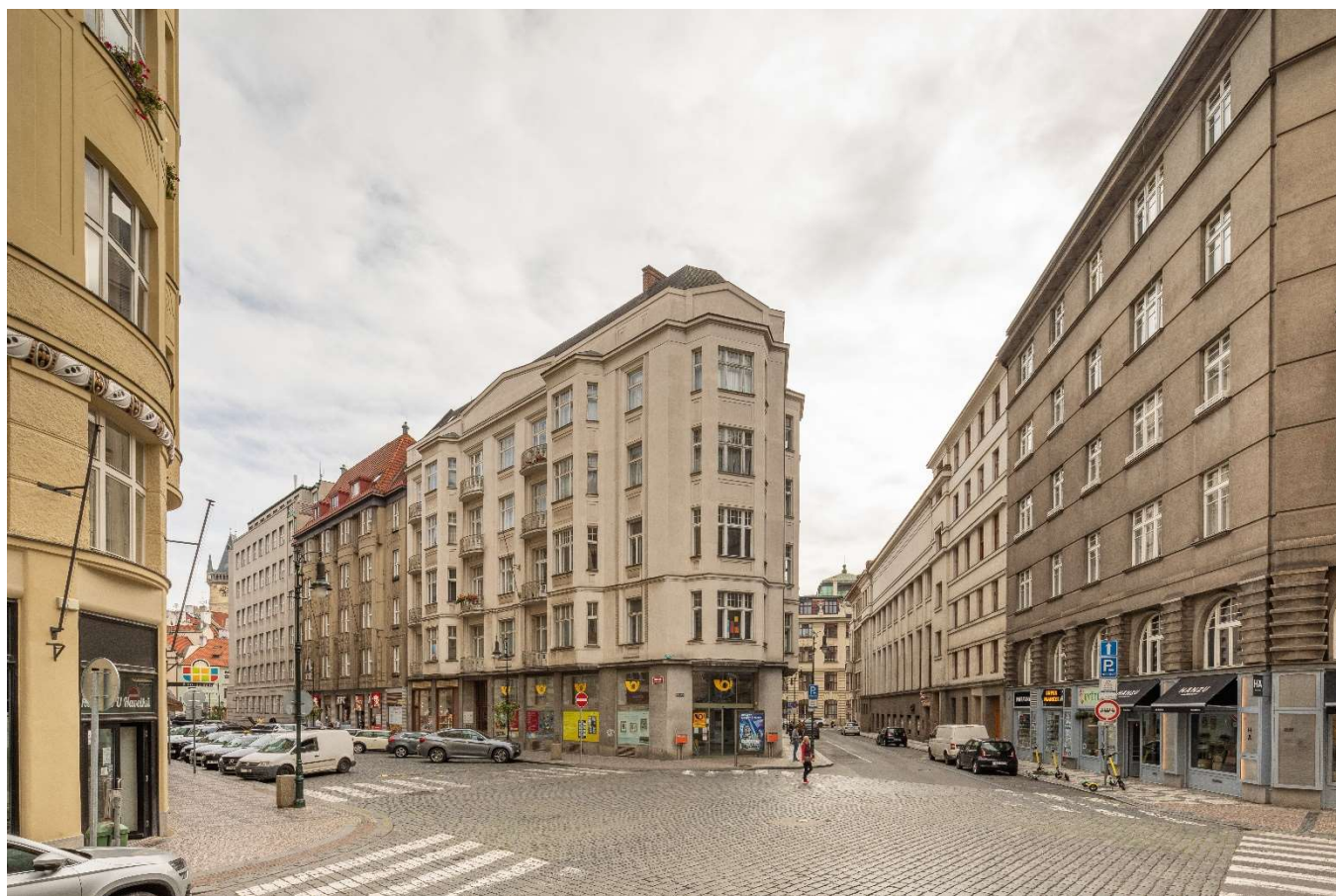
276. Nároží Kaprovy a Žatecké, pohled odpovídající předchozímu snímku, 2020, foto Martin Micka
