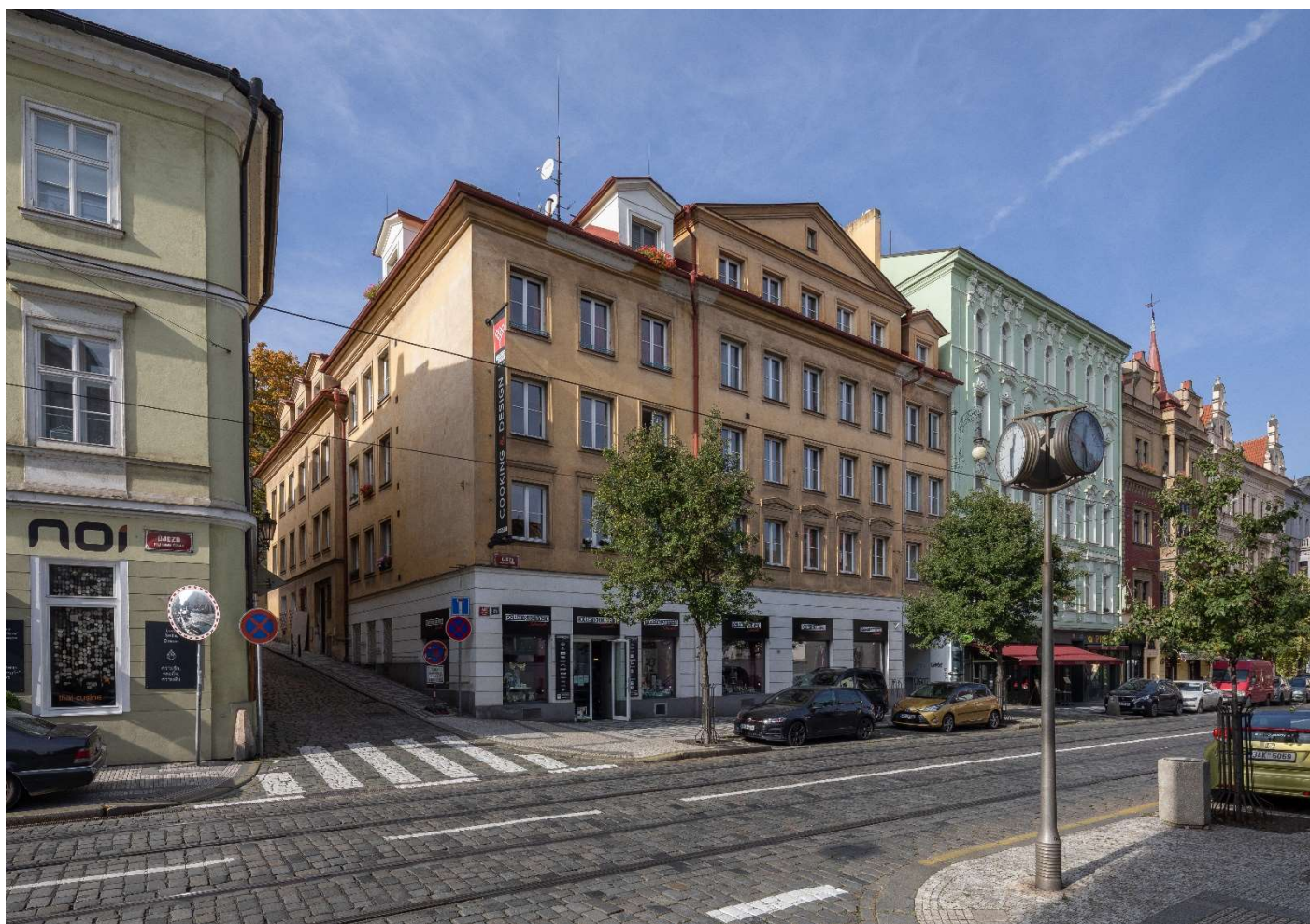
763. Dům čp. 405-III na Újezdě, 2020, foto Martin Micka
