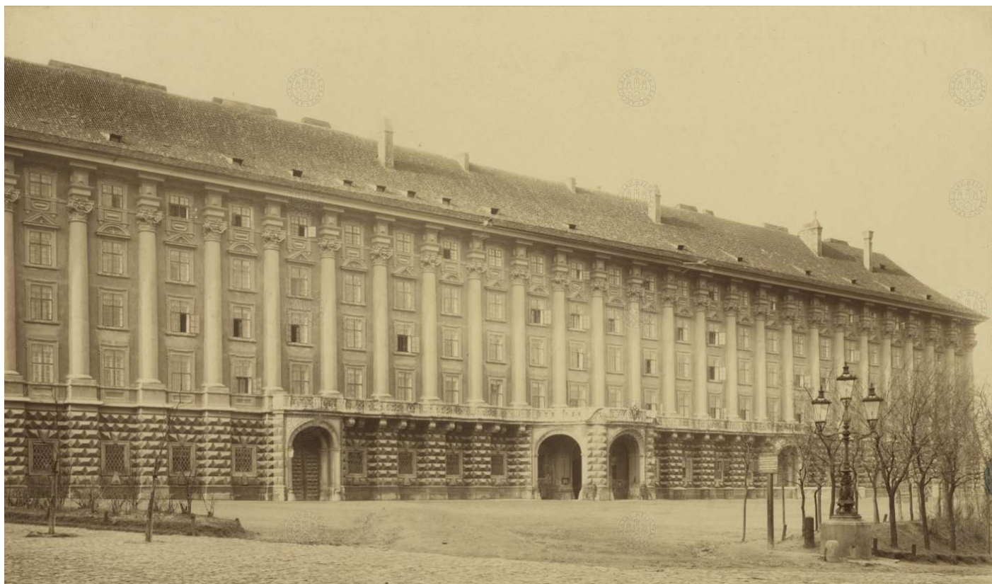
412. Černínský palác čp. 101-IV, stav průčelí po přestavbě na kasárna, kolem 1900, AMP VI 10/23 d
