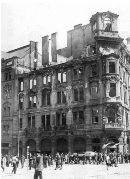
580. Schierův dům čp. 934-I na nároží Pařížské a Staroměstského náměstí po válečném poškození, 1945, AMP I 5470
