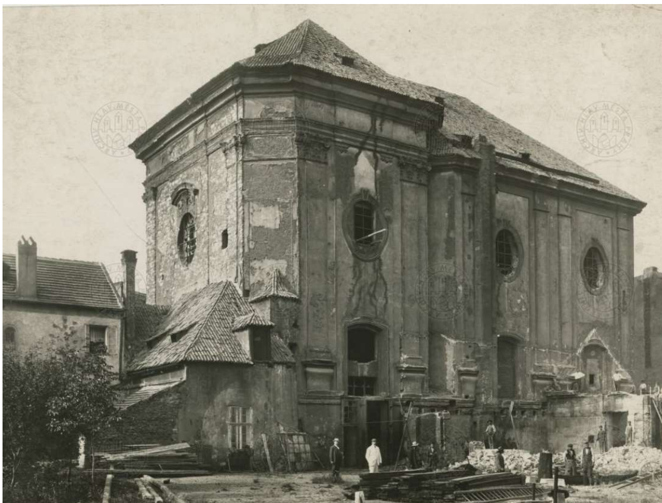
210. Kostel sv. Petra a Pavla na Zderaze, exteriér, 1904, foto Jindřich Eckert, AMP VI 6/15
