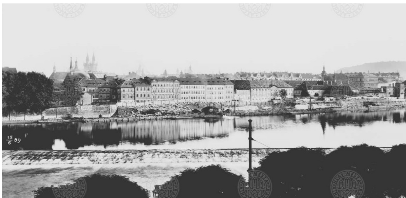
764. Stavba Dvořákova nábřeží v oblasti Františku, 1909, AMP VIII 683
