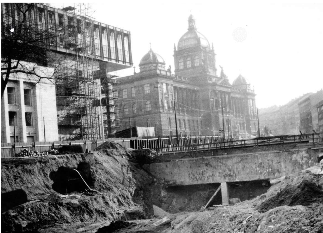
678. Stavba metra u novostavby Federálního shromáždění, 1970, foto Josef Vopravil, AMP I 8397
