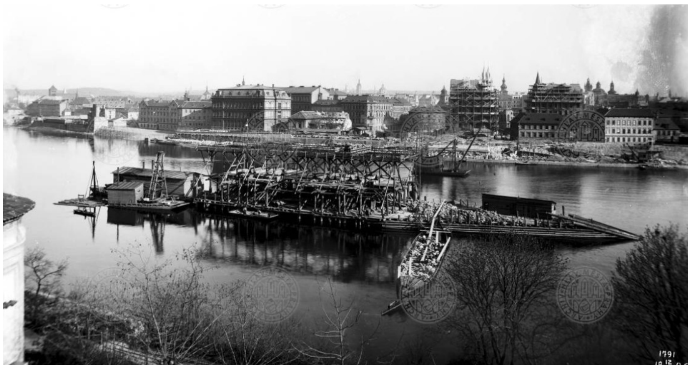
201. Stavba Čechova mostu, 1906, AMP VIII 290
