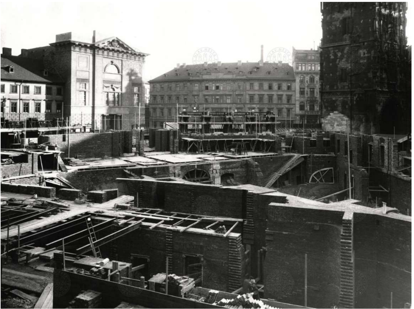
268. Stavba Obecního domu čp. 1090-I, 1906/1907, AMP II 1364
