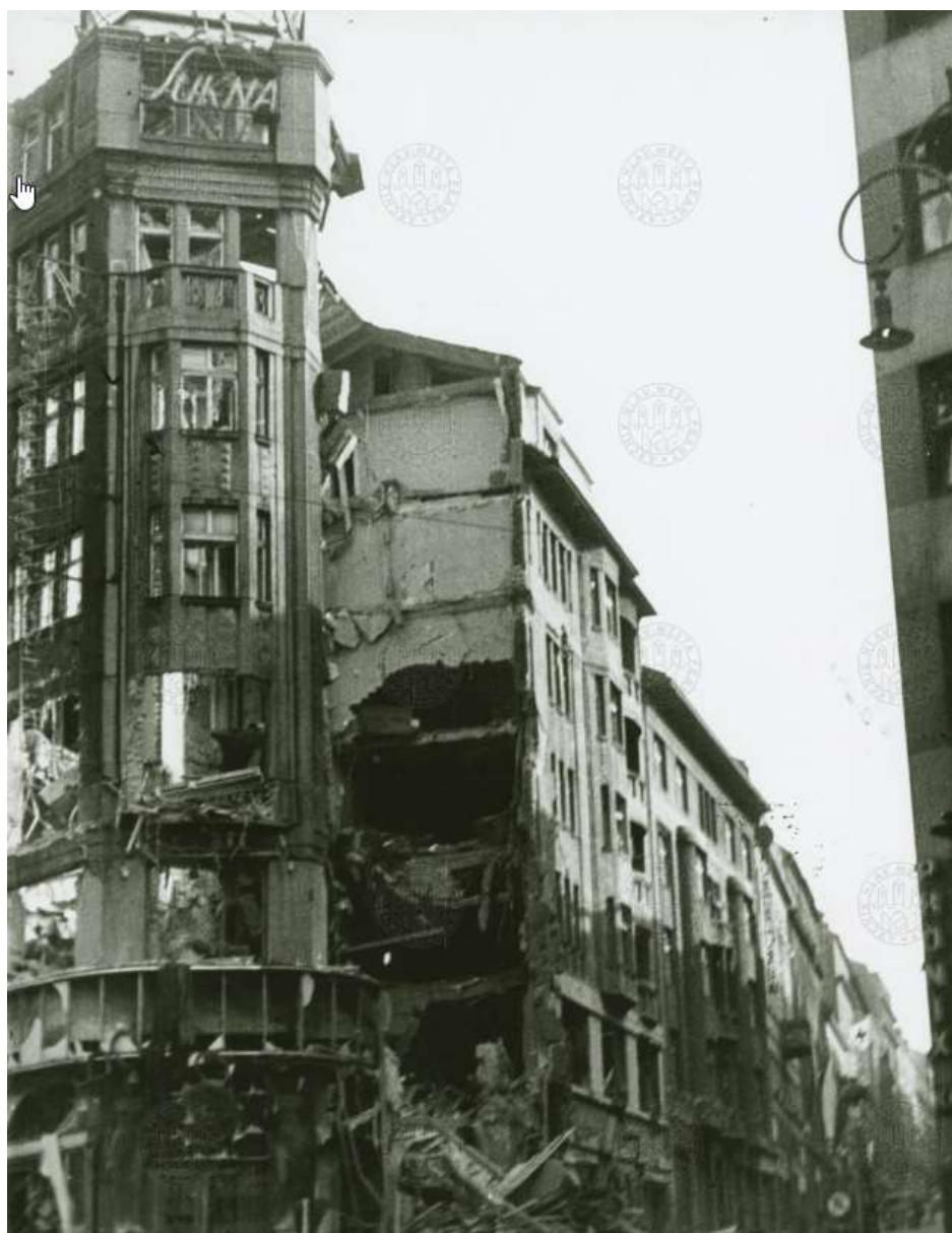
627. Dům čp. 804-II na nároží Krakovské po válečném poškození, 1945, AMP II 1268
