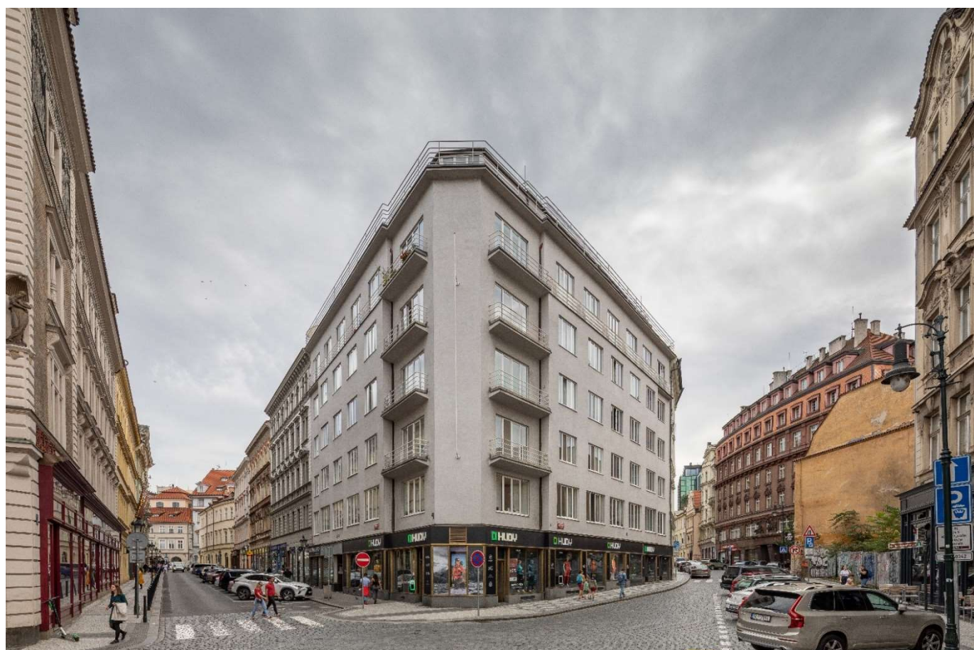
504. Funkcionalistická novostavba domu čp 355-I, pohled odpovídající předchozímu snímku, 2020, Martin Micka
