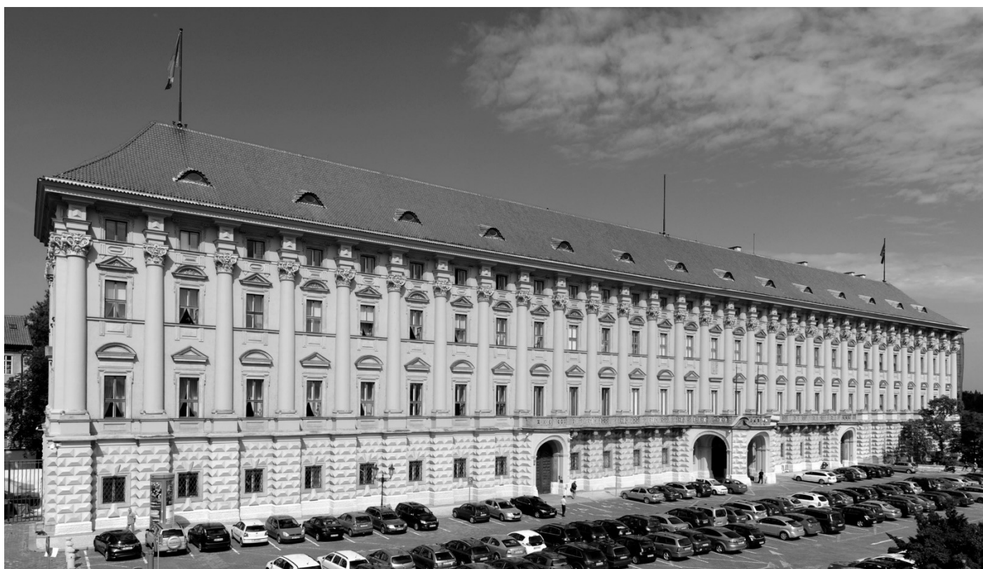
413. Černínský palác čp. 101-IV, průčelí po Janákově rekonstrukci, 2013, foto Martin Micka.
