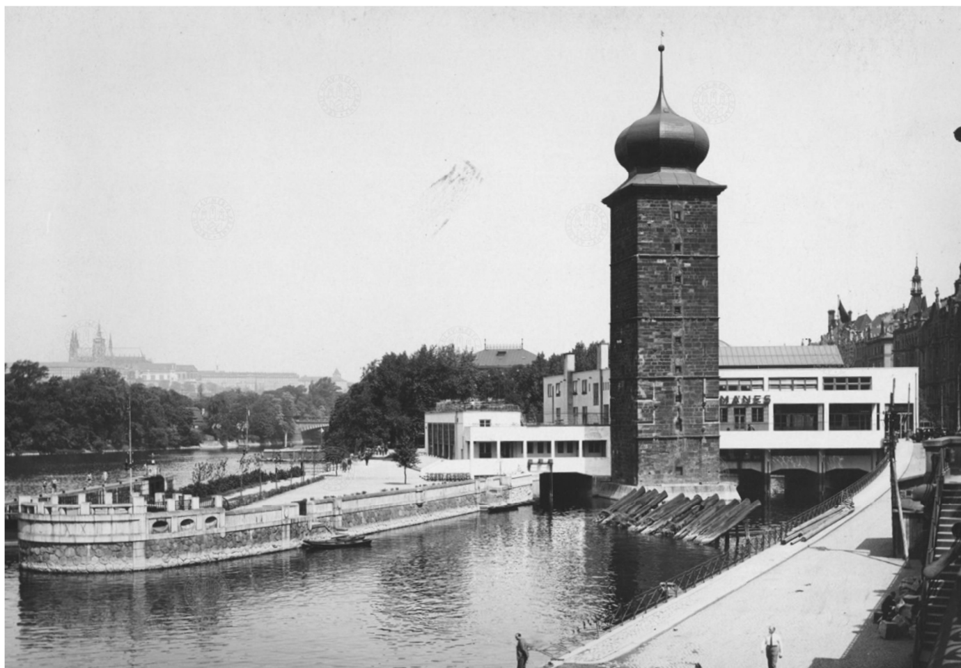
508. Štítkovské vodárny s budovou SVU Mánes čp. 250-II, 1931, foto Antonín Alexander, AMP I 4224
