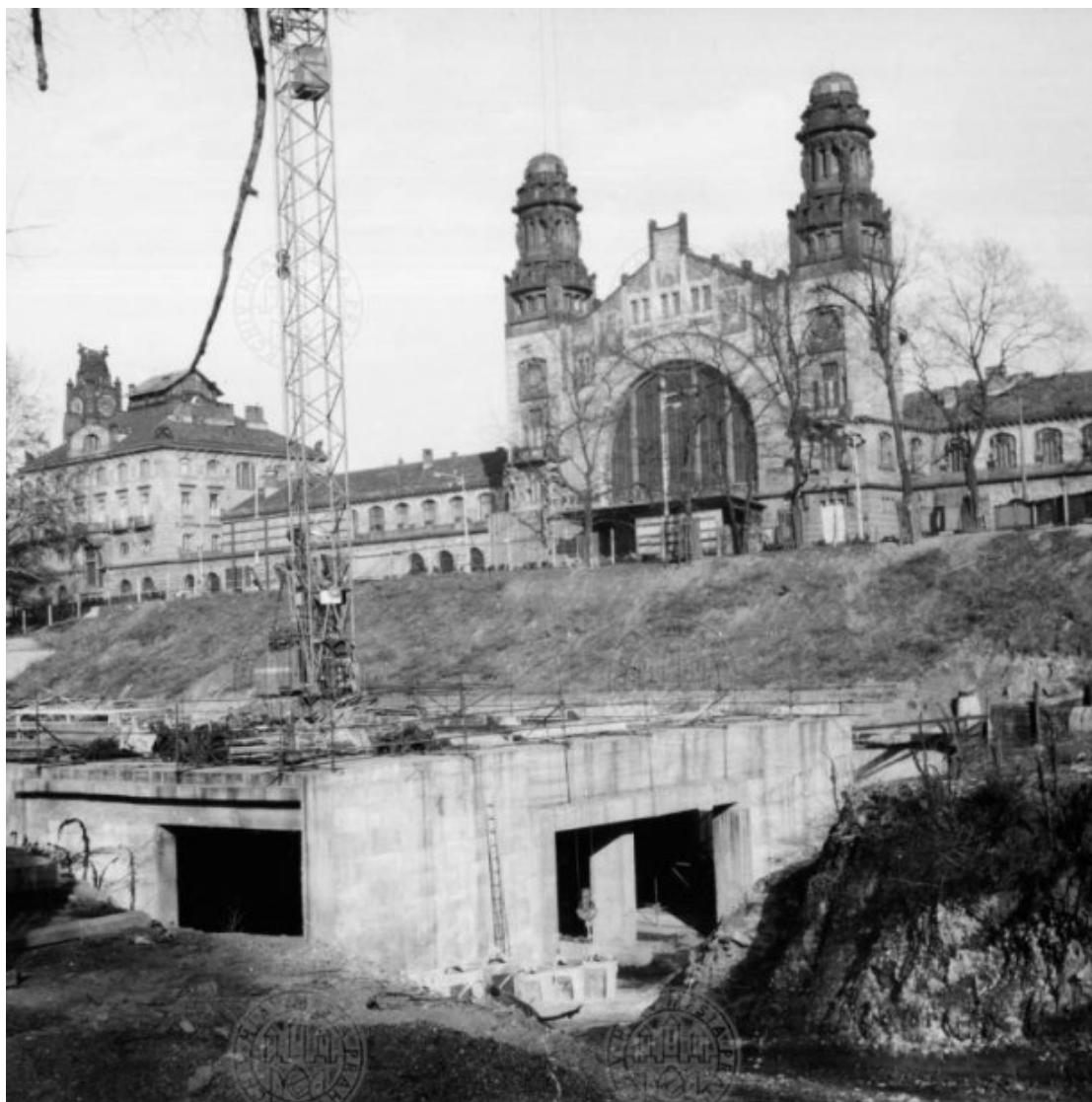
677. Stavba metra před Hlavním nádražím, 1970, foto Josef Vopravil, AMP I 8398
