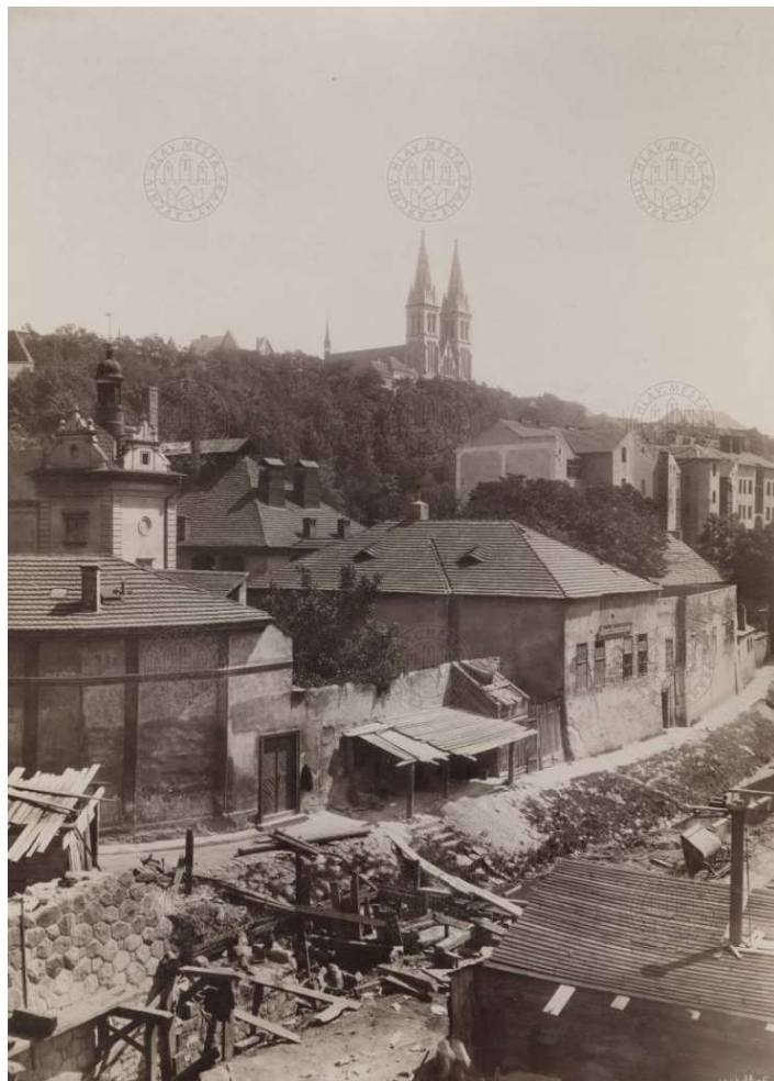
329. Stavba nábreží pod Vyšehradem, 1906, AMP VI 51/1
