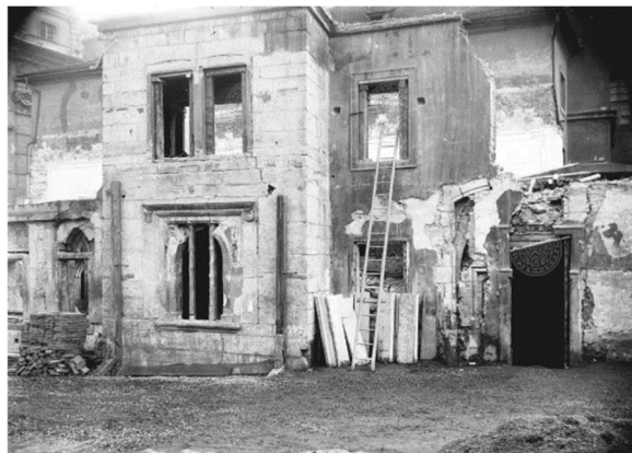
280. demolice starého Křížovnického kláštera 1910, foto Jindřich Eckert, AMP VII 1018
