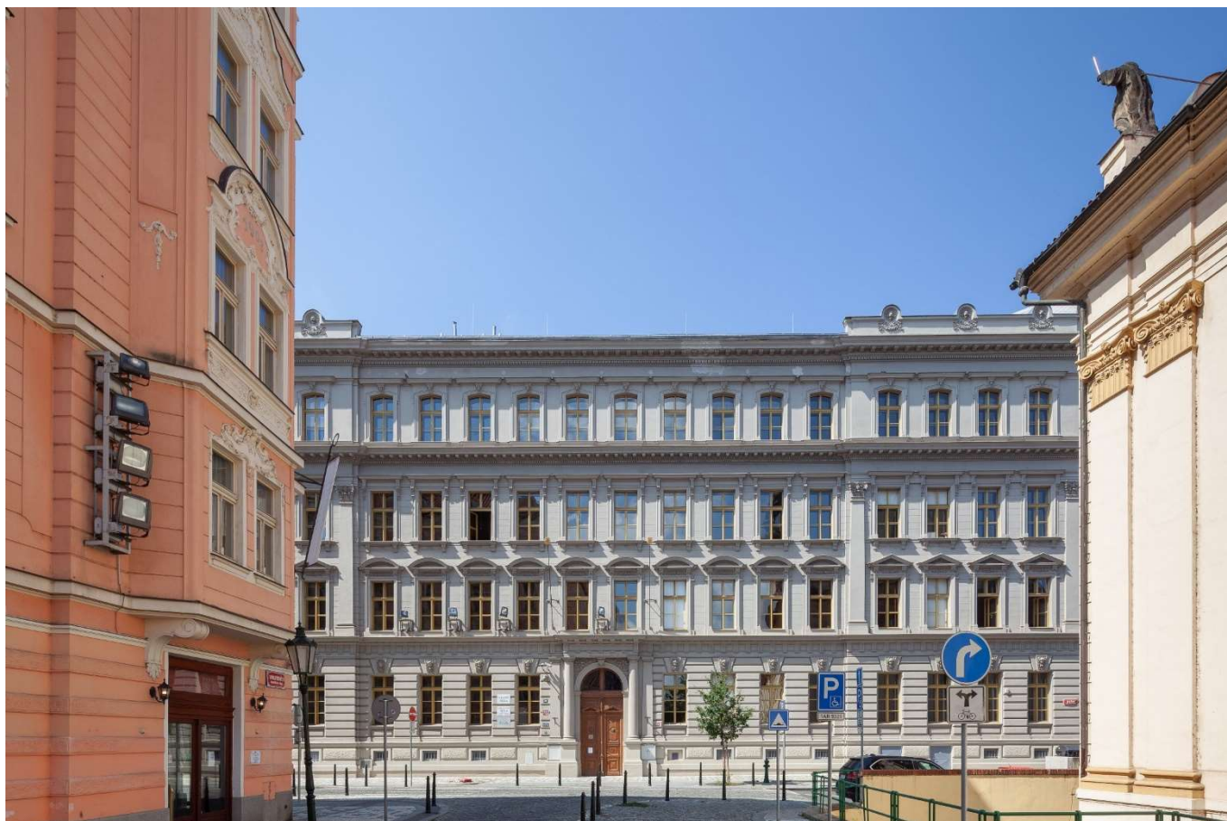
117. Škola na místě kostela sv. Kříže Většího, dnešní stav, foto Martin Micka
