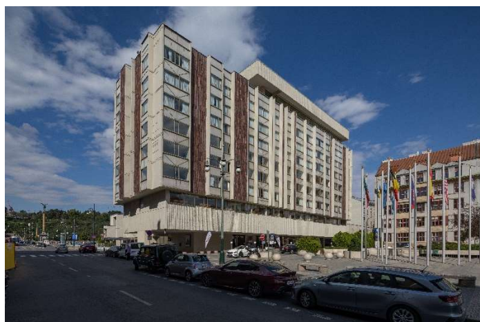
703. Pohled odpovídající předchozímu snímku, 2019, foto Google street view
