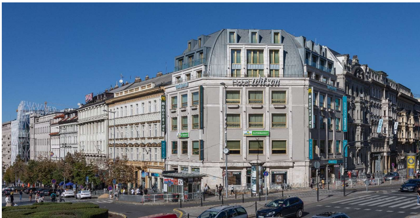
626. Dům potravin čp. 812-I po nástavbě, 2020, foto Martin Micka
