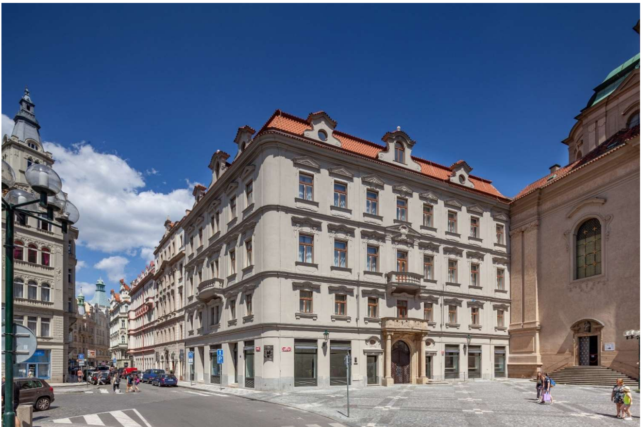
139. Dům čp. 24-I na místě zbořené prelatury, dnešní stav, foto Martin Micka
