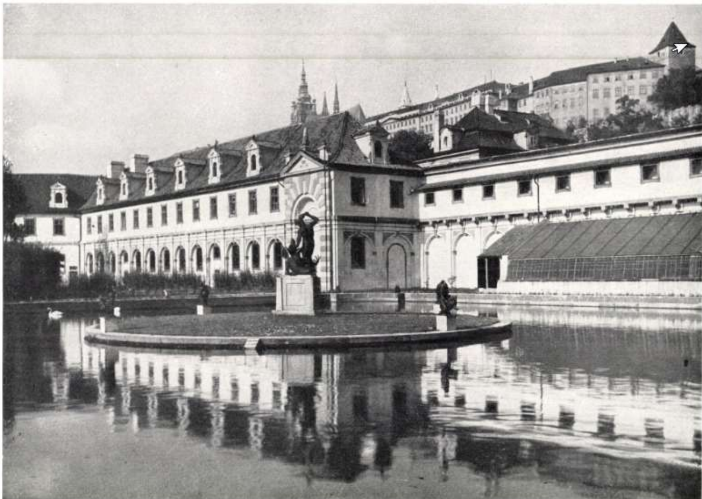
58. Valdštejnský palác. Obnovený bazén s bronzovými kopiemi soch Adriana de Vriese
