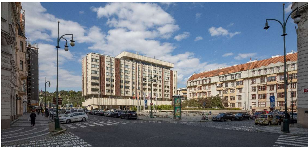
706. Pohled odpovídající předchozímu snímku, 2019, foto Google street view
