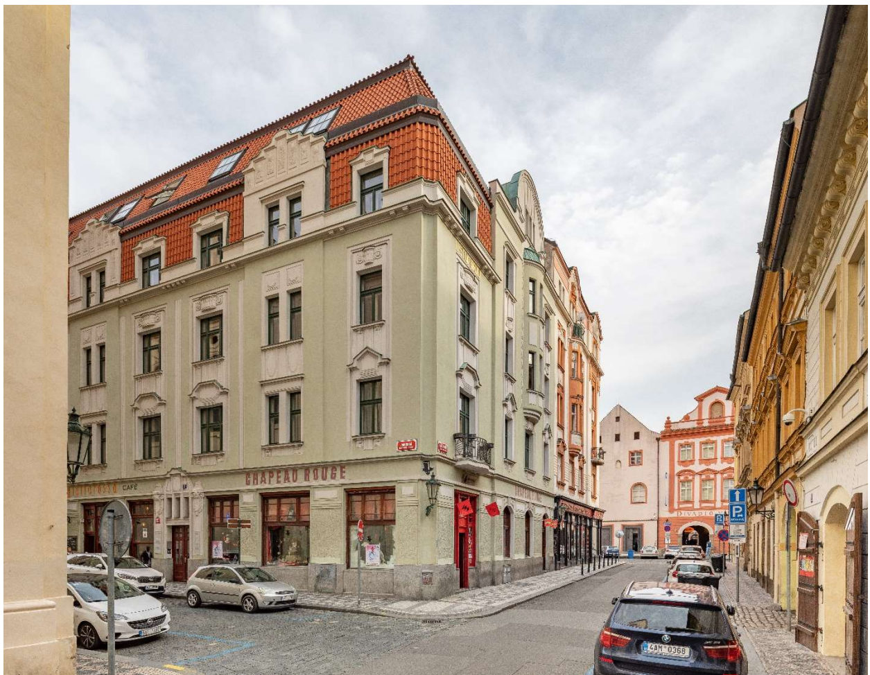
215. Blok na místě domu U Štupartů čp. 647-I, pohled od kostela sv. Jakuba, 2020, foto Martin Micka
