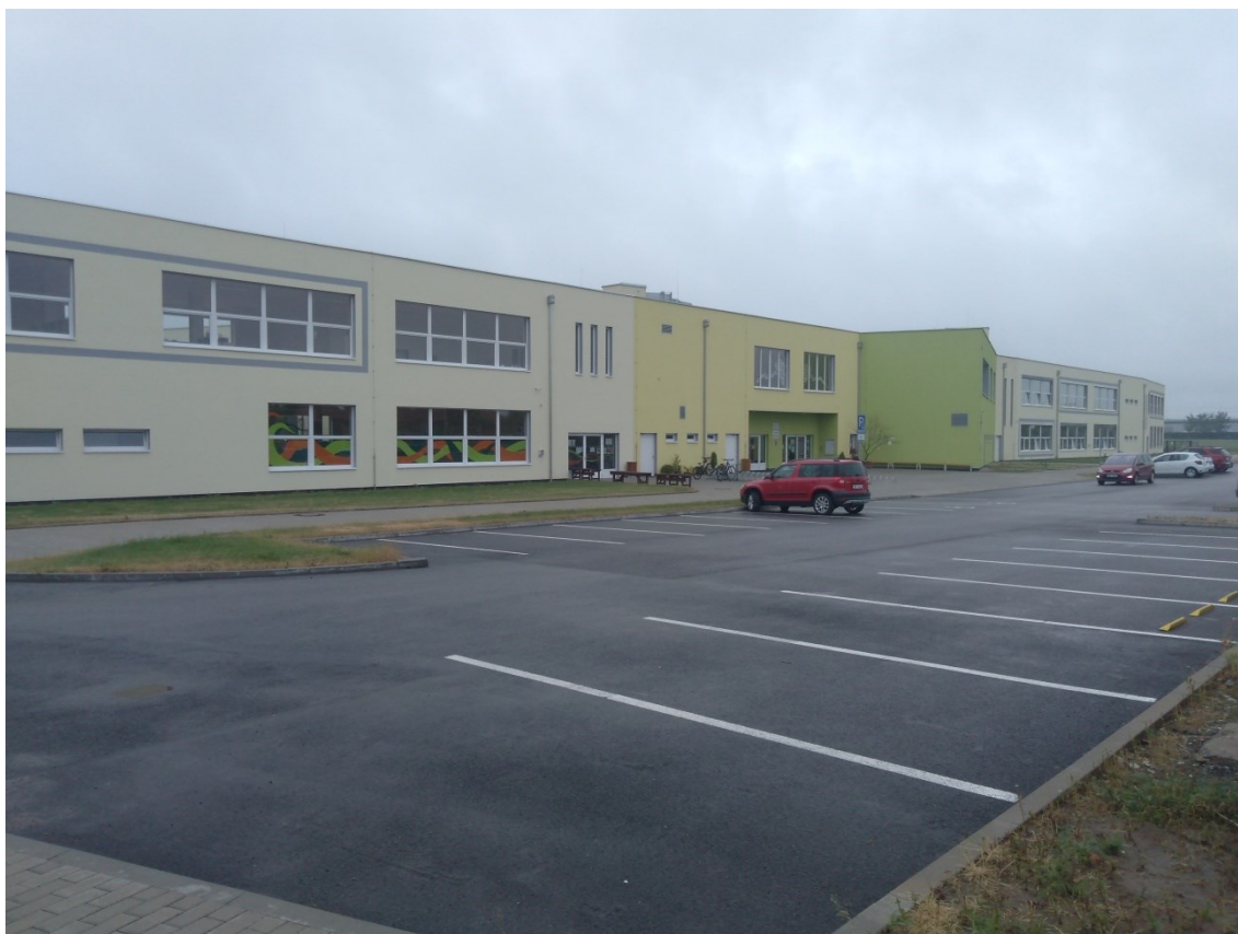
Nová budova základní školy (22. 6. 2021)
