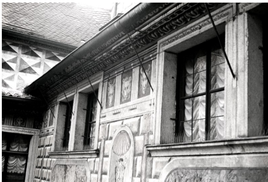
30. Český Krumlov, III. nádvoří zámku, detail vrchního patra s maskami, 1574–1577
