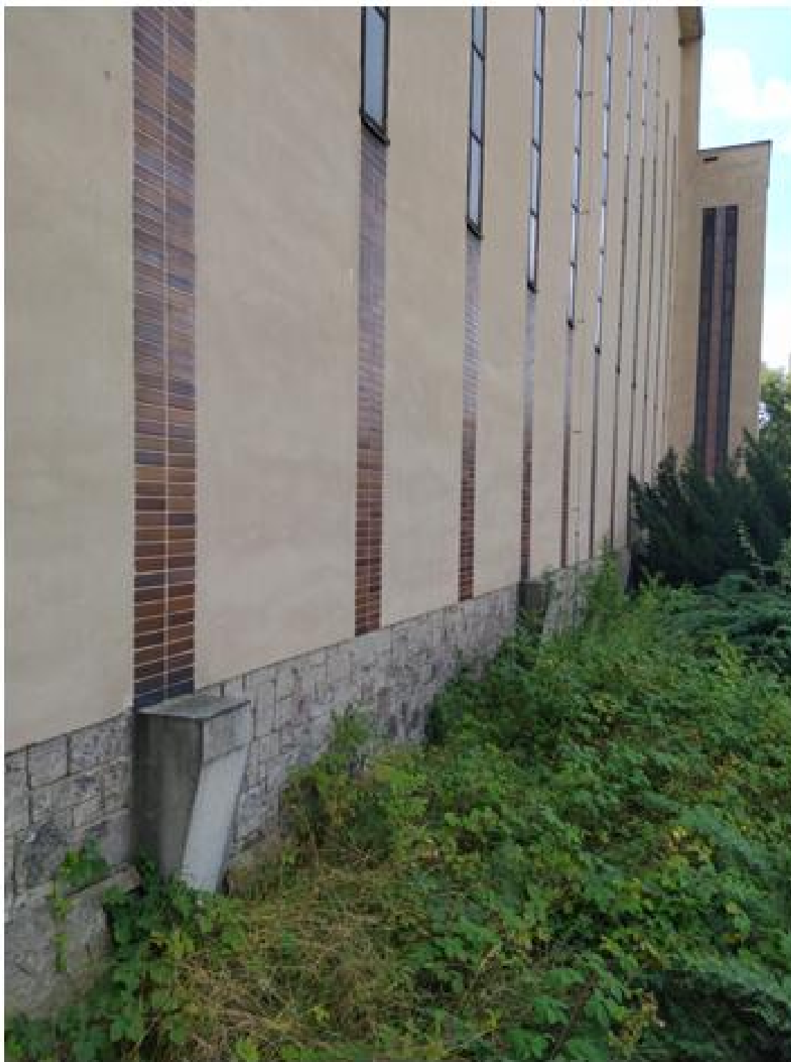
23. Praha-Košíře, severní stěna s kamennými podstavci, kostel sv. Jana Nepomuckého, pohled od severovýchodu. Foto: autor.
