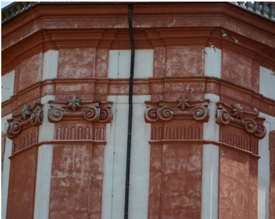
[28] Mariánská Týnice, kostel Zvěstování Panny Marie, detail fasády s barokně kompozitními hlavicemi pilastrů s vloženými hvězdicemi
