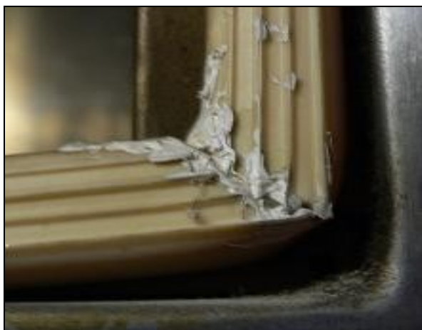
obrázek č. 3. Oprava rohu těsnění silikonem
