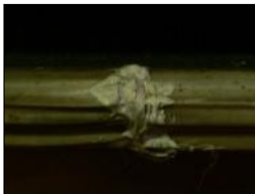
obrázek č.2. Oprava těsnění silikonem
