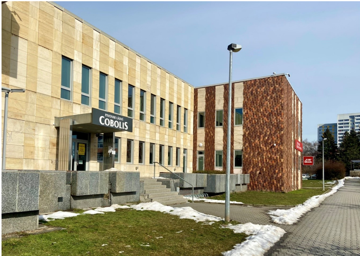
Obr. č. 100: Pohľad na fasádu z juhovýchodnej strany. Foto: autorka.
