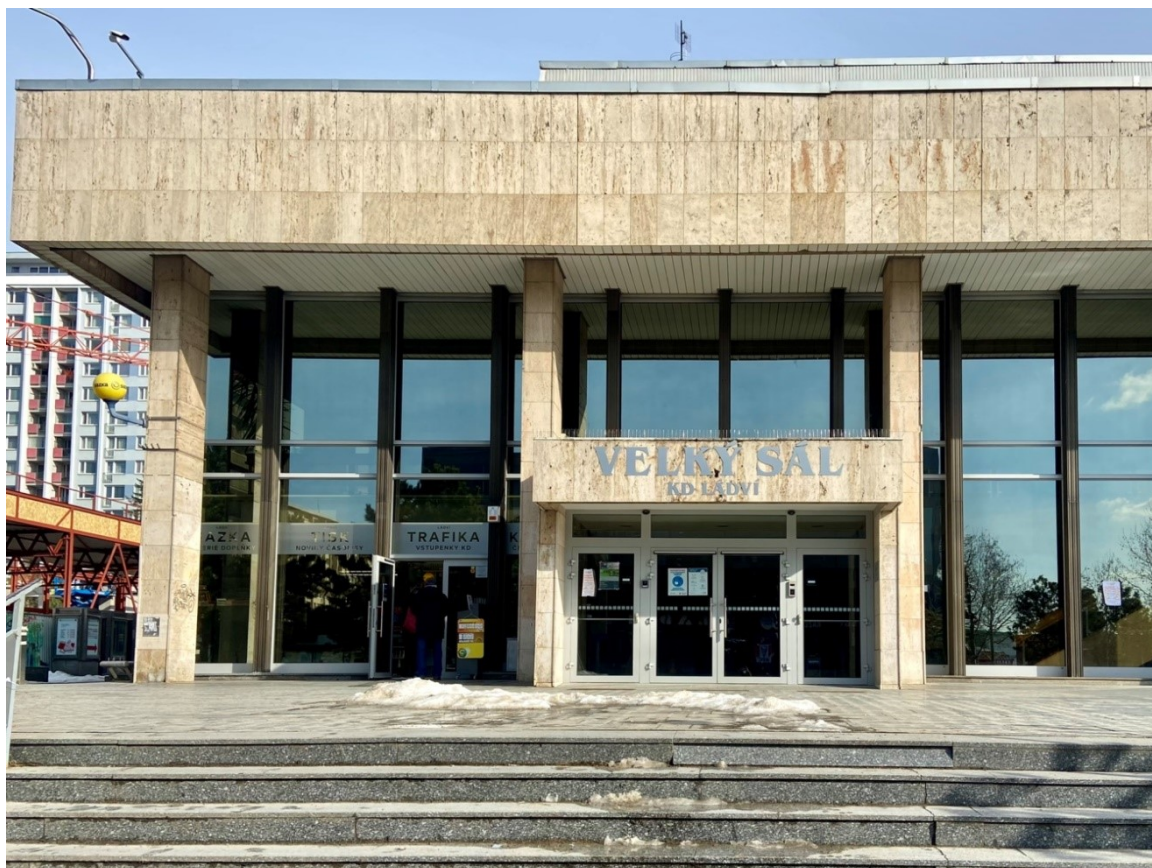
Obr. č. 98: Pohľad na vstupné priečelie KD. Foto: autorka.
