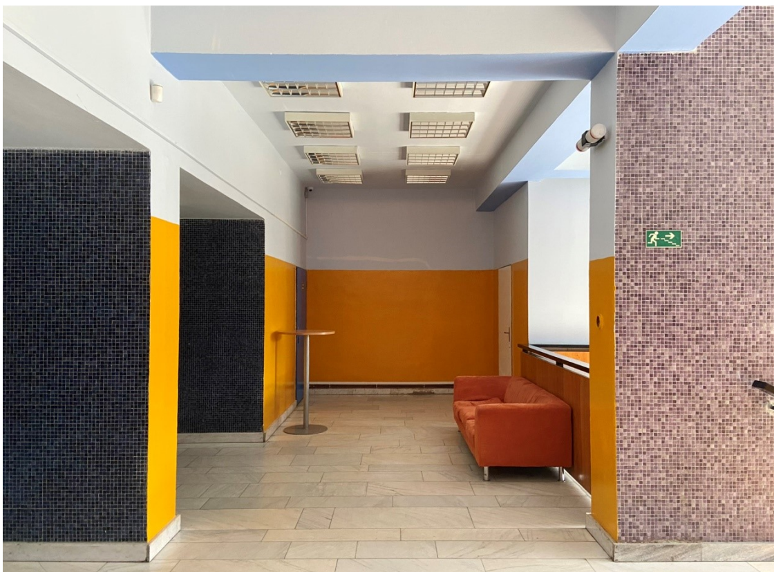
Obr. č. 64: Mozaikové obloženie stien interiéru na chodbách MSD. Foto: autorka.
