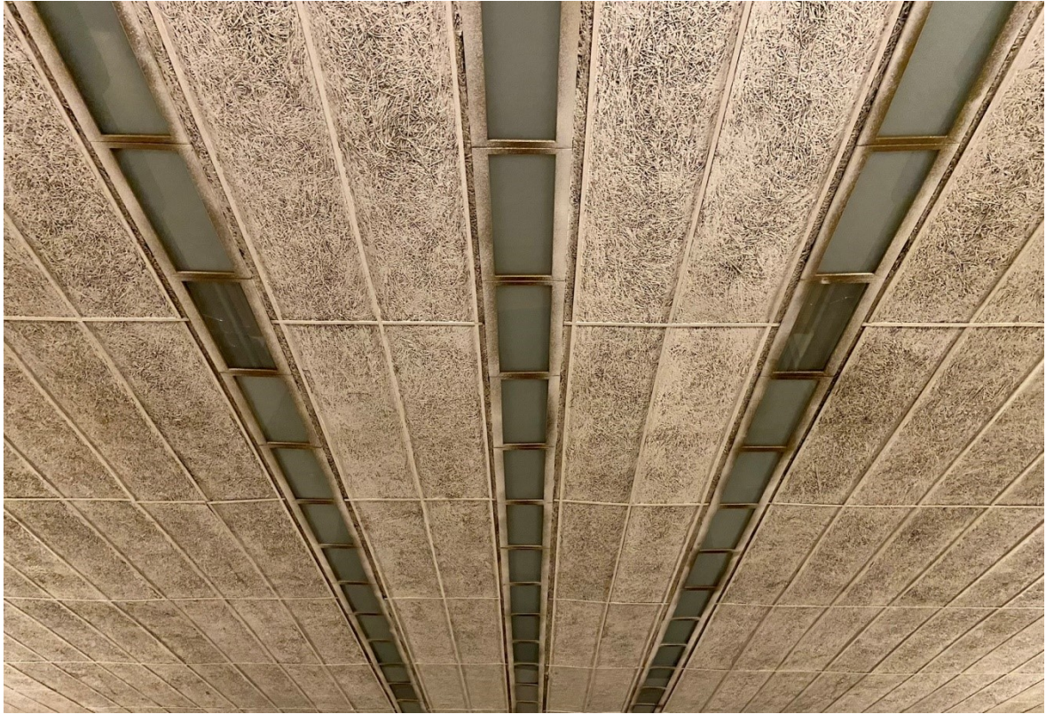
Obr. č. 25: Detail riešenia stropu a osvetlenia v hlavnej sále. Foto: autorka.
