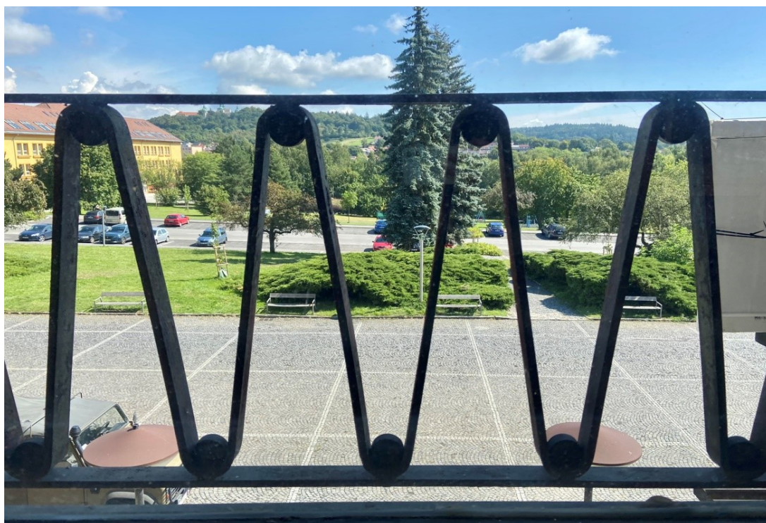
Obr. č. 46: Zábradlie na budove KD v exteriéri. Foto: autorka.
