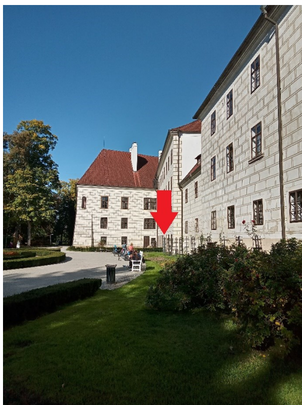
Obrázek č. 12: Pohled na vstup do DP z prostoru příchodu od zámeckého nádvoří, tedy z místa, odkud směrem k DP přichází nejpodstatnější část návštěvníků. Červená šipka označuje nedostatečně označený vstup do Domu přírody. Fotografie autora.
