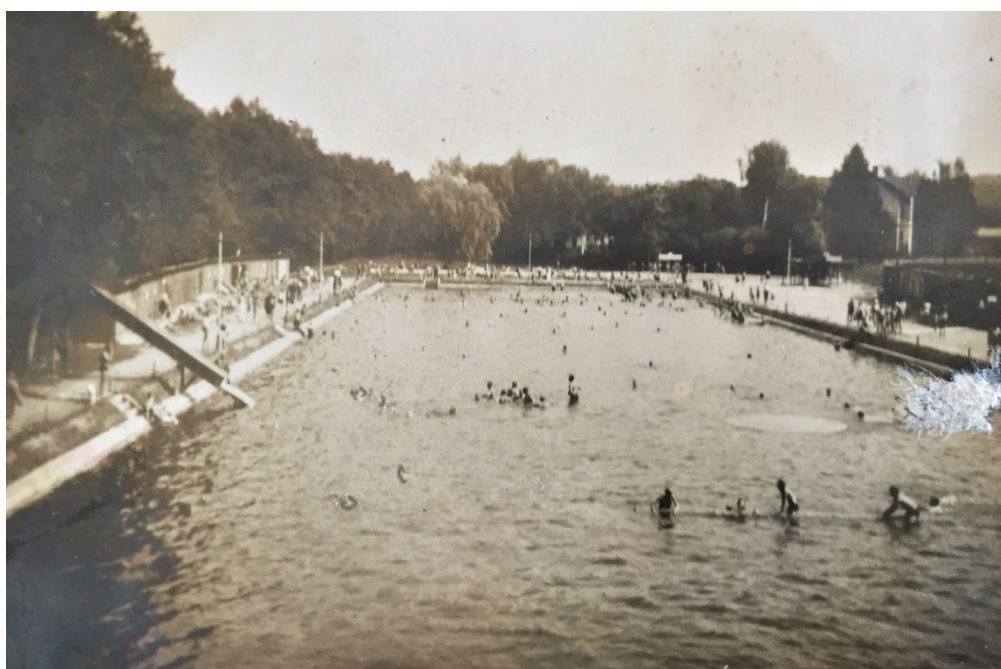
88. Koupadla na Sladovce v Benešově – bazén, stavitel František Scharf, 1933
