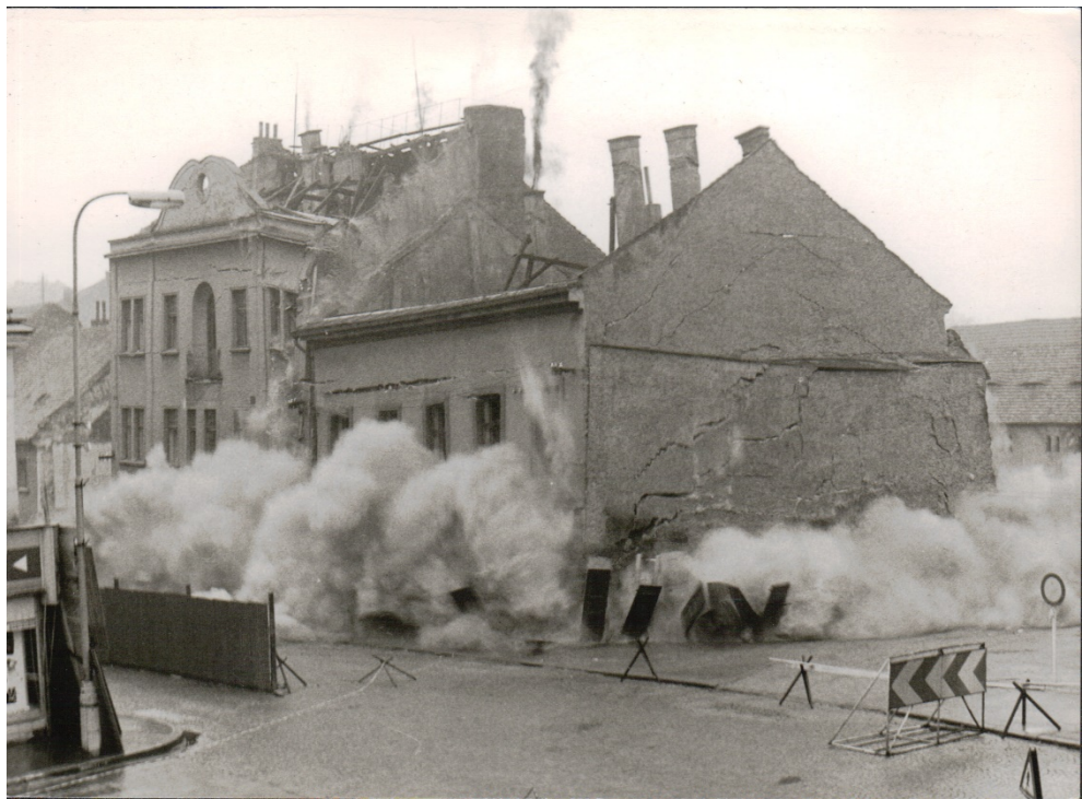
112. Demolice domů na východní straně Malého náměstí v Benešově (včetně domu čp. 41), 1974
