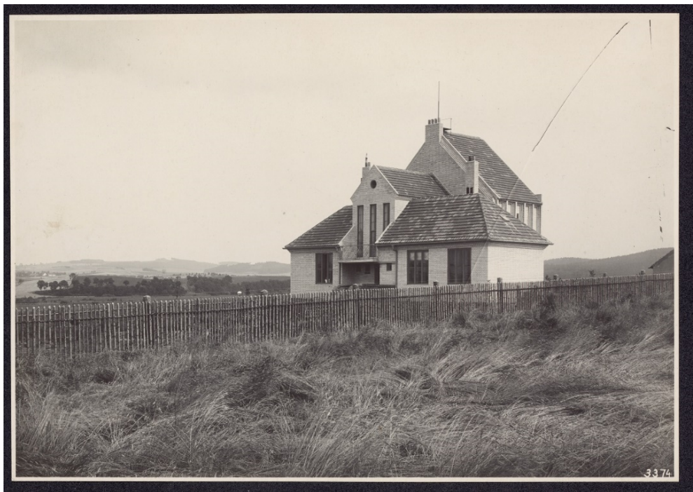
25. Vila J. Váni v Benešově, architekt Otakar Novotný, 1911–1912
