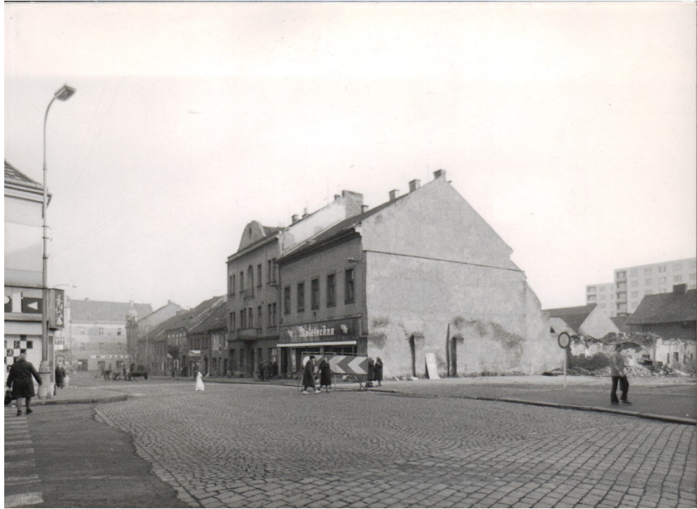
111. Dům čp. 41 rodiny Veselých v Benešově (před demolicí), rekonstrukce podle návrhu architekta Otakara Fischela, 1930
