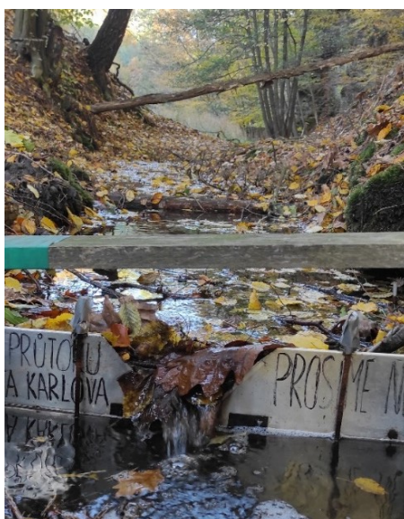
Obr. 3.8: Přeliv na Pšovce 24.10.2021 před pročištěním (Foto autor)
