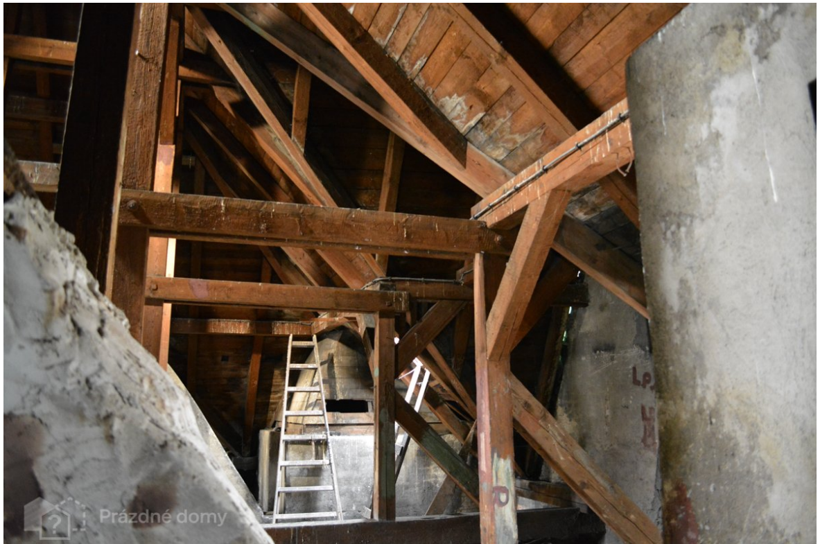
Příloha 11 Střecha vyšehradského nádraží 2013, zdroj: Prázdnédomy.cz
