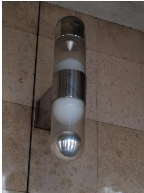
63. Josef Kochrda: Osvětlovací tělesa 1985, kov, sklo, výstup stanice Karlovo náměstí
