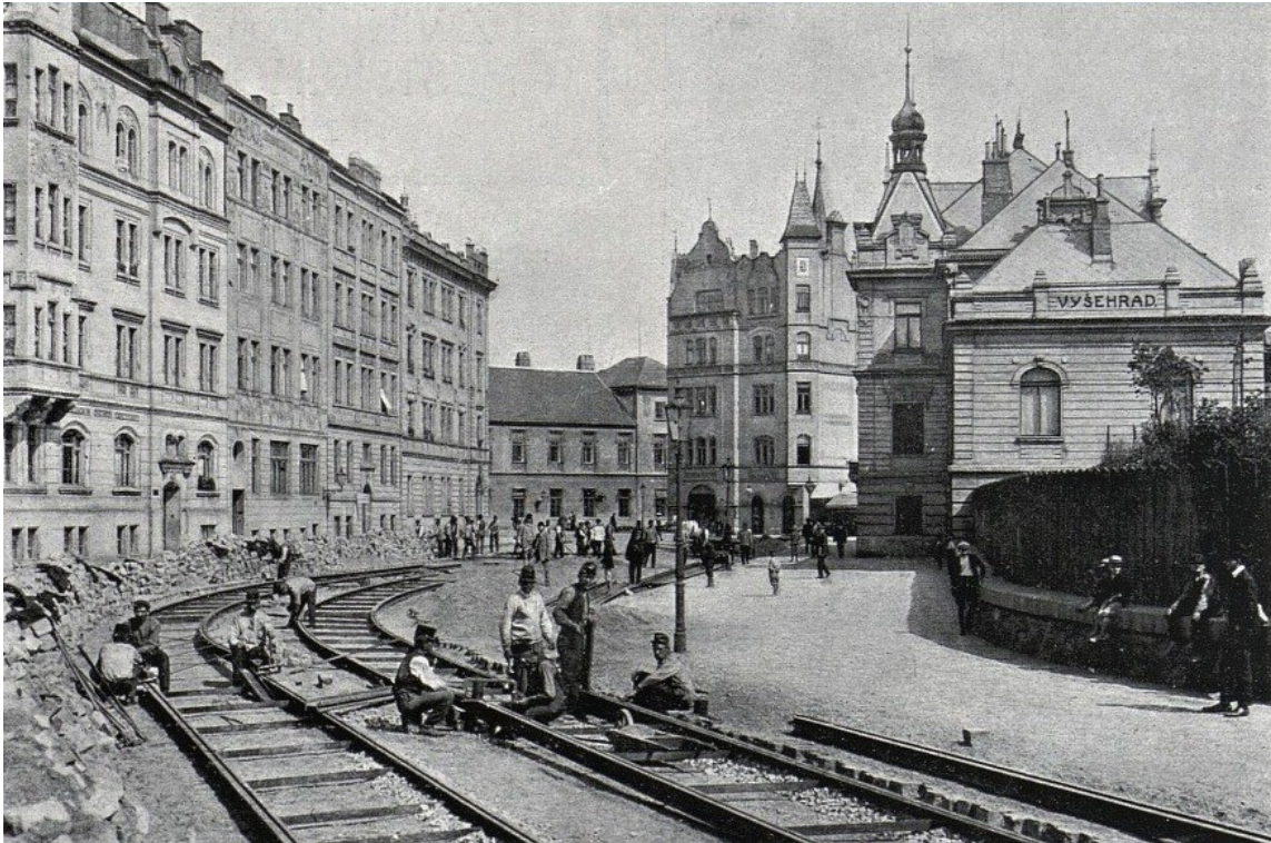
3. Dobová fotografie – stavba tramvajové trati – rok neznámý
