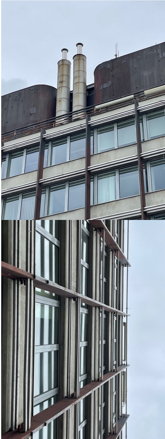
[29], [30] Jan Haněl, administrativní budova Vojenských staveb v Praze – detail střechy a fasády, Česká republika, 1973–1982.
