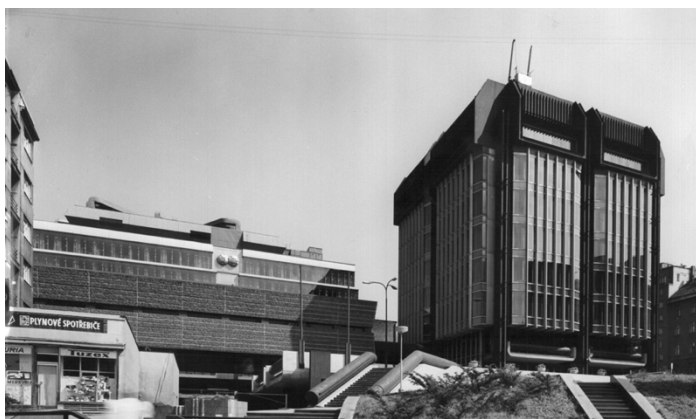
[38] Ivo Loos, Jindřich Malátek, Jan Eisenreich, Václav Aulický, stavba plynárenského řídicího centra Transgas v Praze, Česká republika, 1966–1978.
