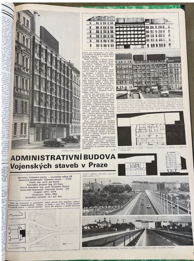
[32], [33] Periodikum Československý architekt – dobová zpráva a historický pohled na budovu.
